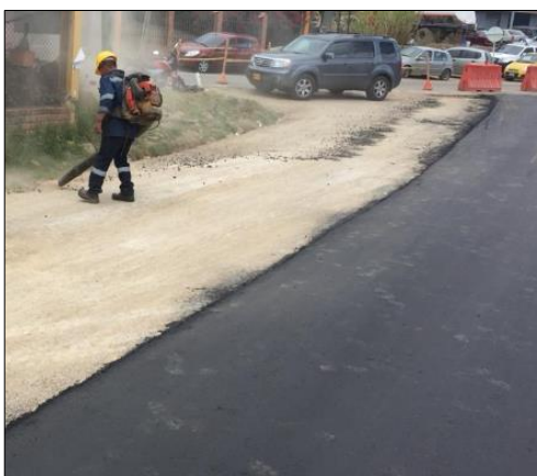
Imagen 11 Limpieza de Base
