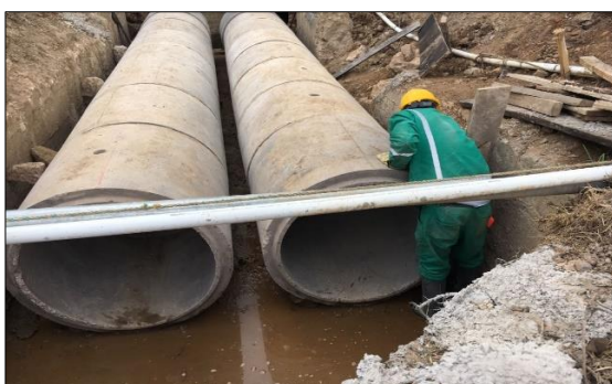
Imagen 5 Instalación de Tubería de 36”
