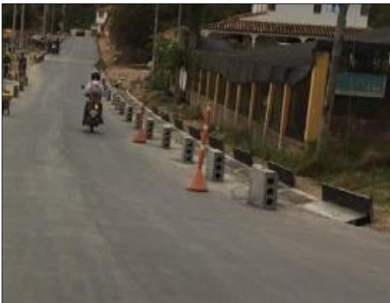
Imagen 19 Construcción de Cuneta
