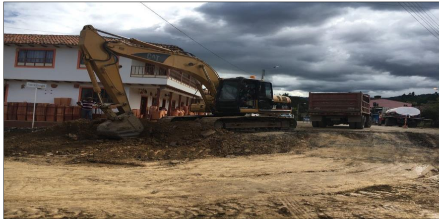
Imagen 2 Remoción de la estructura de pavimento
