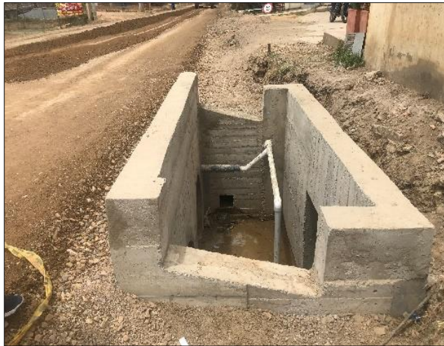
Imagen 9 Construcción de Realces de Cabezales
