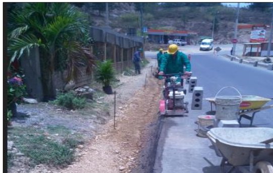
Imagen 16 Corte de Pavimento
