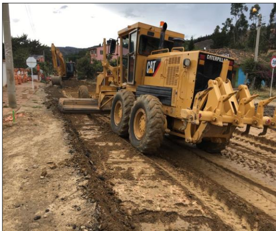
Imagen 6 Extendida y compactación de Sub-base granular
