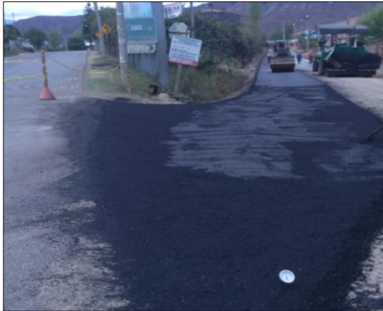
Imagen 13 Extendida de mezcla asfáltica con Pavimentadora
