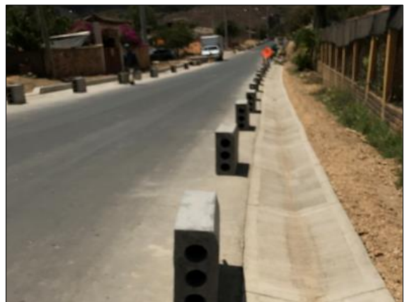
Imagen 18 Instalación de Sardinel prefabricado
