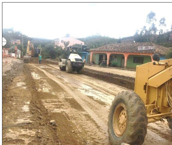
Imagen 7 Compactación de Sub-base Granular
