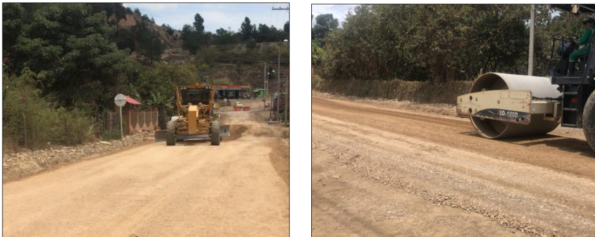
Imagen 10 Extendida y Compactación de Base Granular
