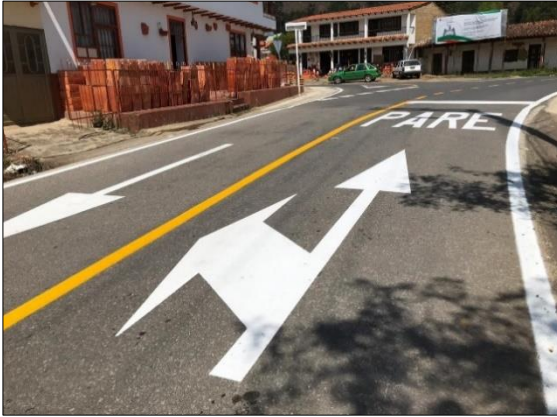
Imagen 22 Demarcación vial o Señalización horizontal
