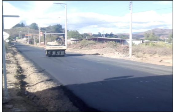
Imagen 14 Compactación de mezcla asfáltica con compactador neumático
