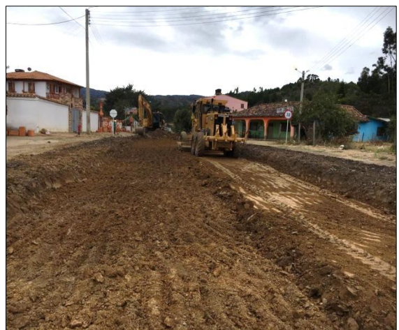
Imagen 6 Extendida y compactación de Sub-base granular
