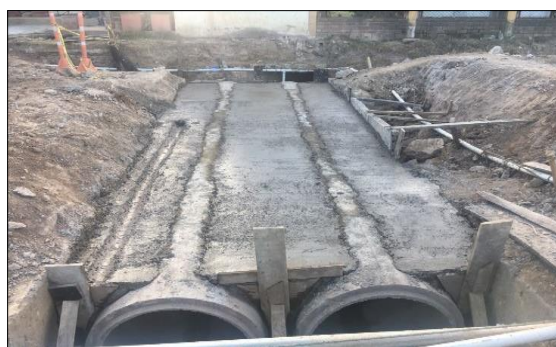
Imagen 4 Atraque de la Tubería
