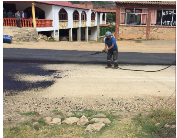
Imagen 12 Riego de imprimación con emulsión asfáltica
