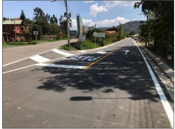
Imagen 22 Demarcación vial o Señalización horizontal
