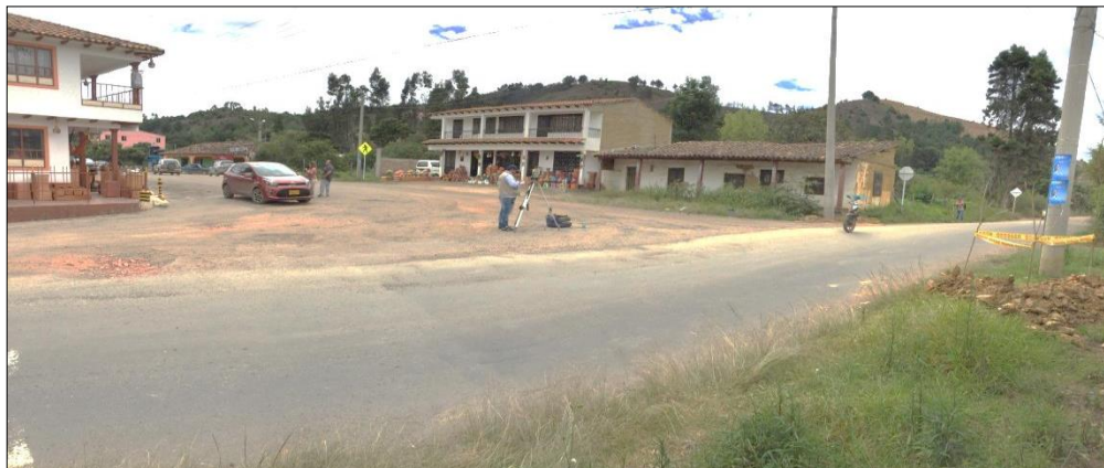
Imagen 1 Replanteo con equipo topográfico
