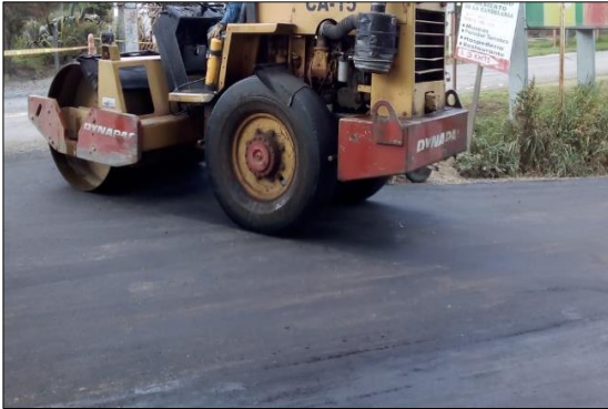
Imagen 15 Compactación de mezcla asfáltica con vibro compactador
