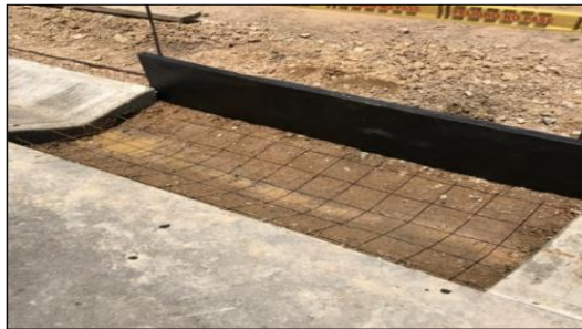
Imagen 17 Armado de acero de refuerzo
