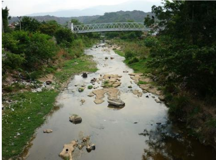
Figura 20. Fotografía del Rio de Oro. Puente Peatonal Antigua Batea:
