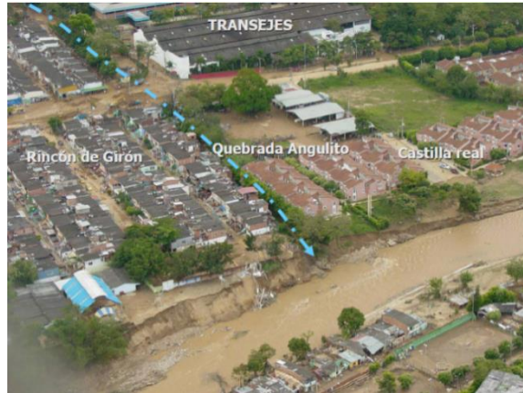
Figura 111. La erosión en las curvas del río es una de las amenazas principales en las orillas del río.
