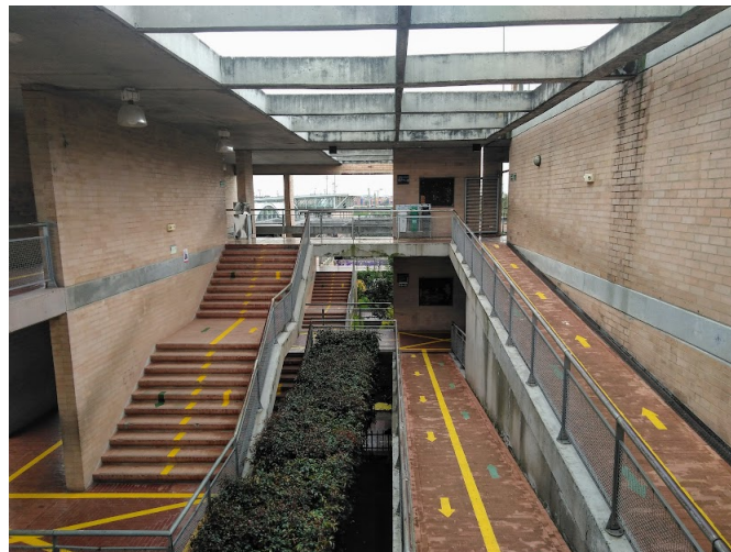
Figura 42: Señalización pasillos Colegio Carlos Pizarro Leongómez.
