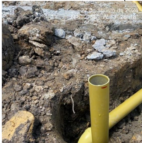
Ilustración 11. Pruebas de estanqueidad.
