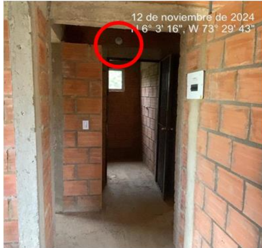
Ilustración 14. Traslado salida de lampara.
