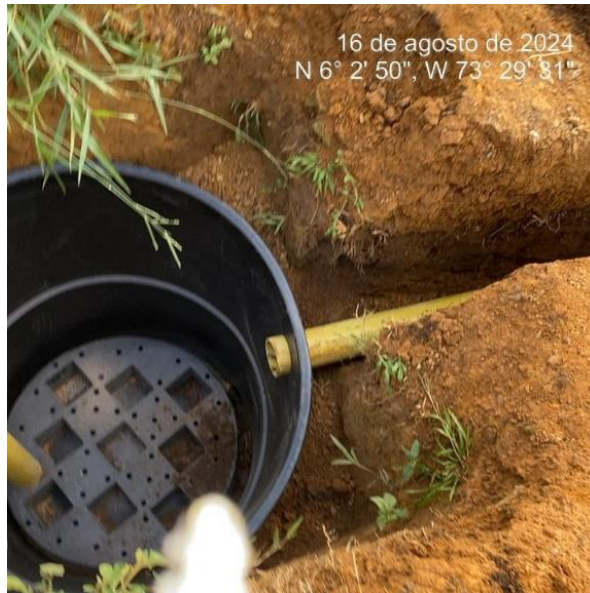
Ilustración 29. Tanque séptico.
