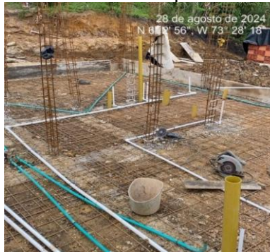
Ilustración 12. Instalación de puntos hidrosanitarios
