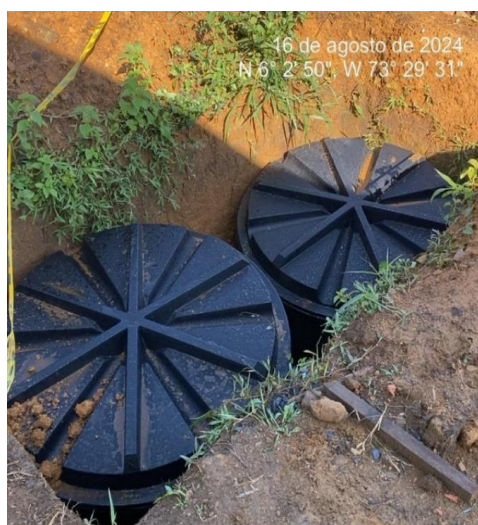
Ilustración 19. Instalación sistema séptico.
