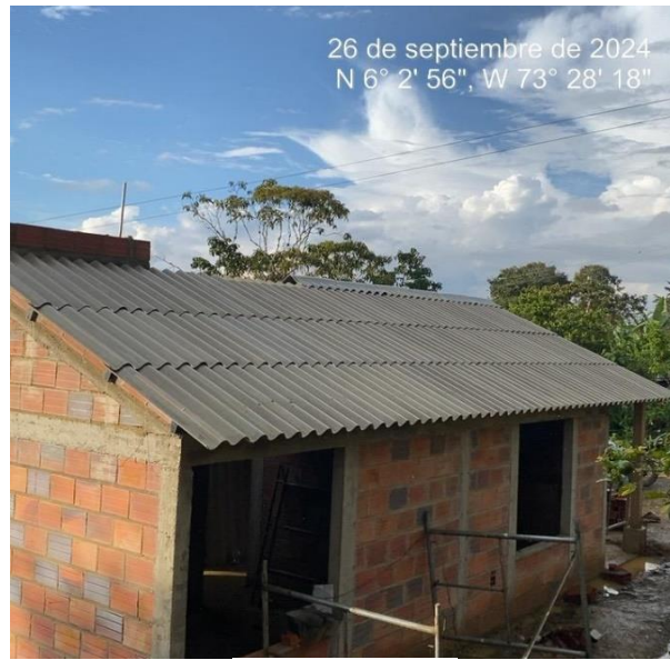
Ilustración 16. Instalación de cubierta.
