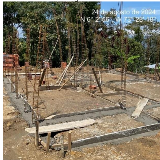
Ilustración 7. Vigas de cimentación.
