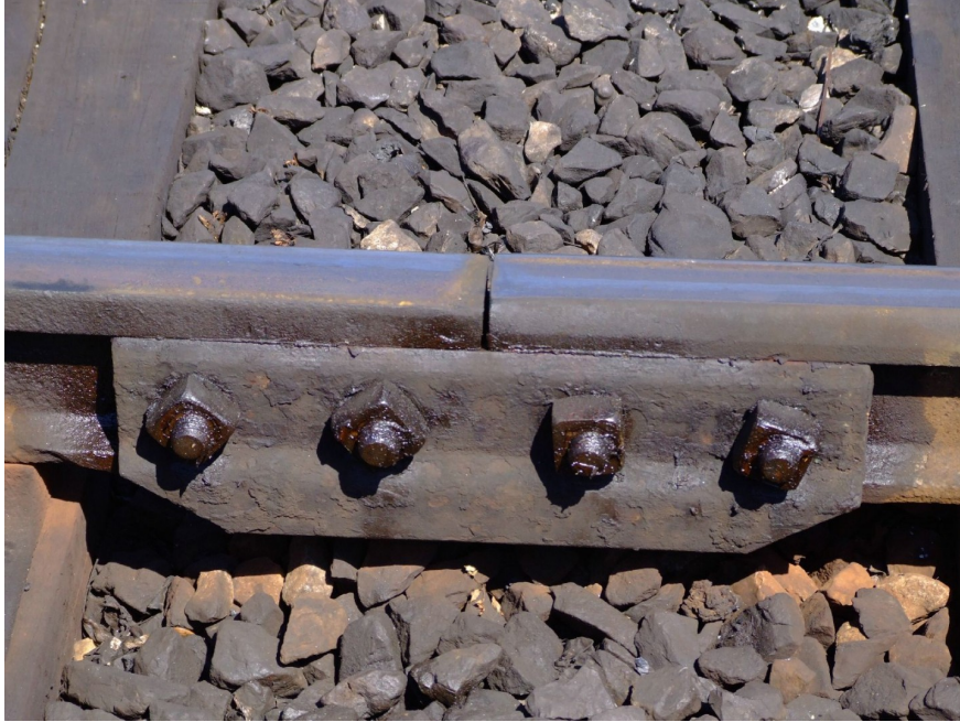
Figura 4. Juntas de dilatación.
