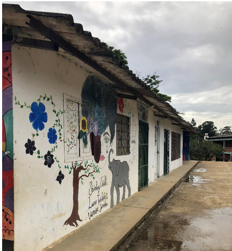
Figura 27. Condición actual del bloque de primaria.
