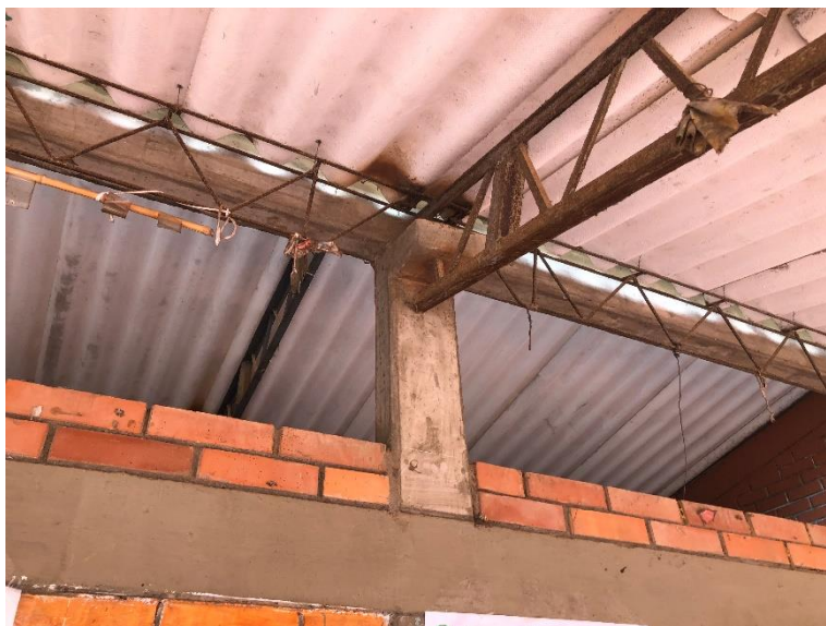
Figura 28. Estructura, materialidad e instalaciones eléctricas.
