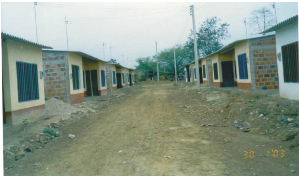
CUBIERTA EN TEJA DE ASBESTO Y PLACA PARA TANQUE AEREO
