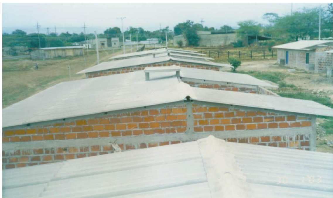
CABALLETE EN ASBESTO
