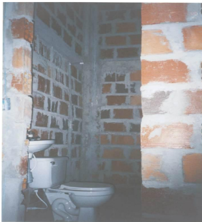
PINTURA EN VINILO SOBRE MURO TIPO 1
