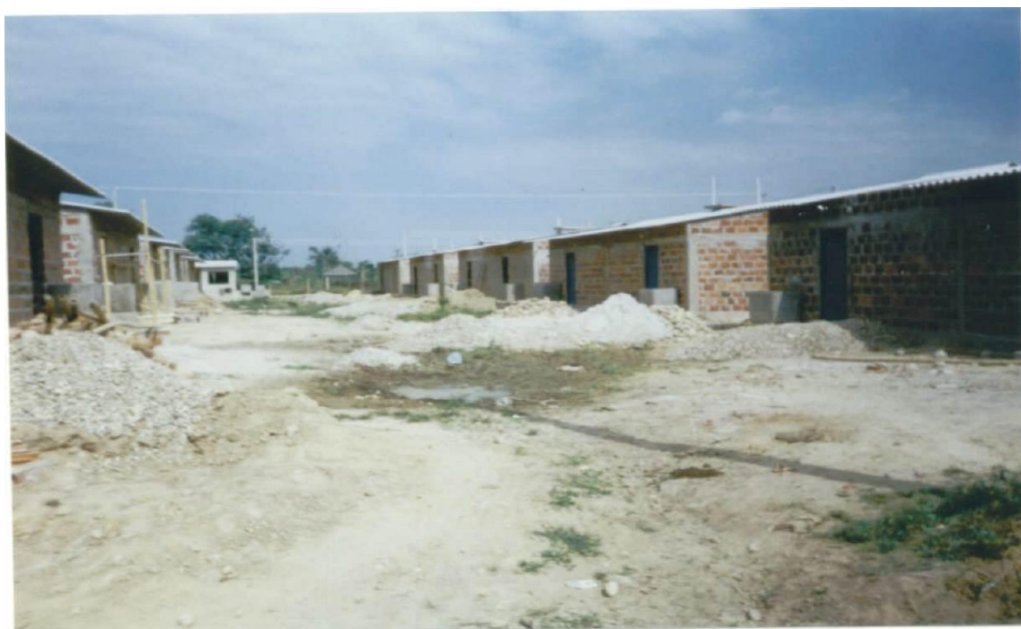
CONSTRUCCIÓN DE MESONES EN CONCRETO
