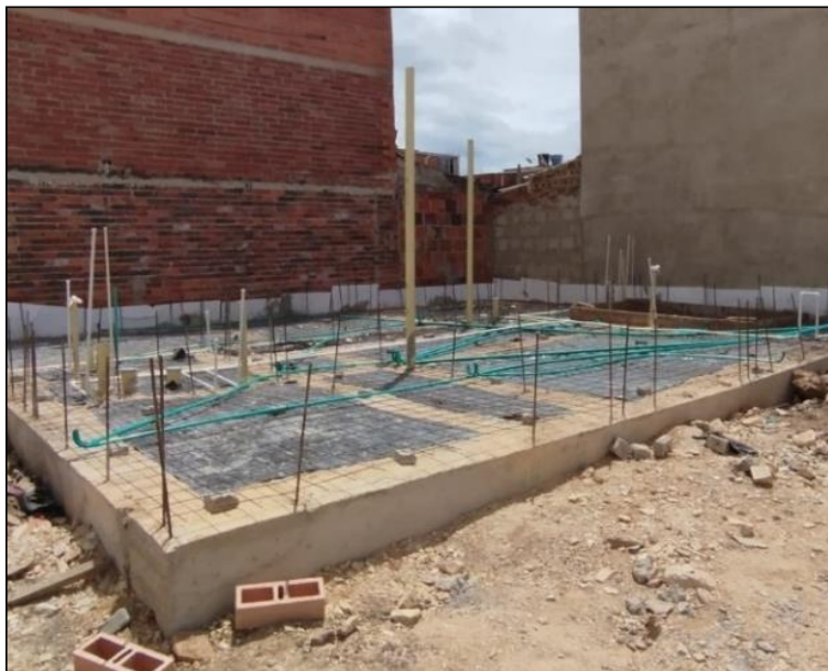
Figura 15. Elaboración placa de contrapiso.
