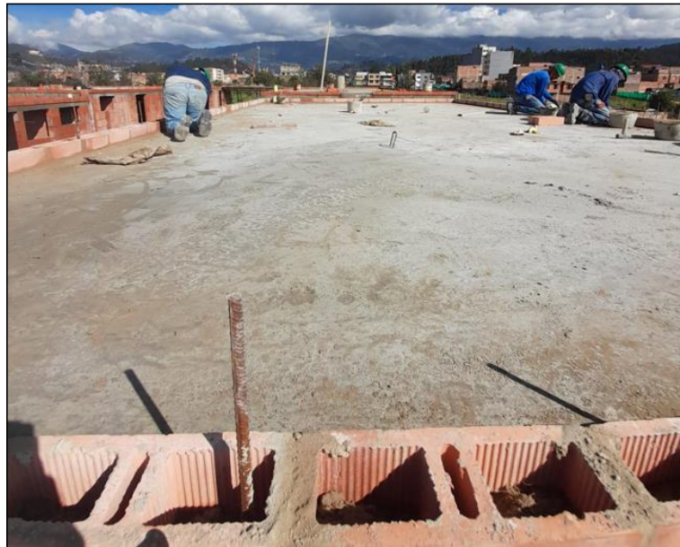
Figura 11. Placa de cubierta posterior al curado del concreto.
