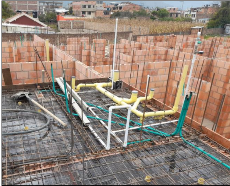
Figura 9. Armado placa de entrepiso.
