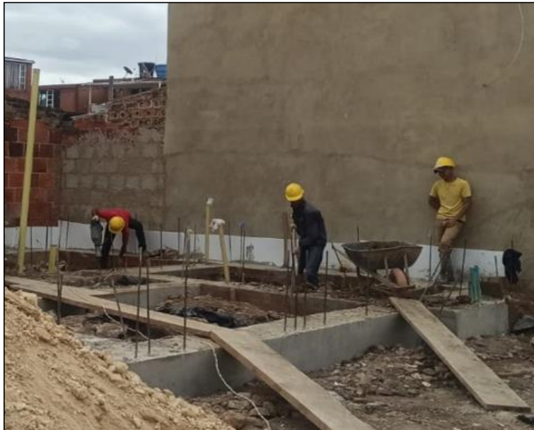
Figura 14. Excavación para la cimentación del proyecto Guadalupe.
