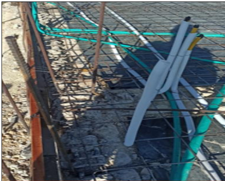
Figura 6. Viga de cimentación.
