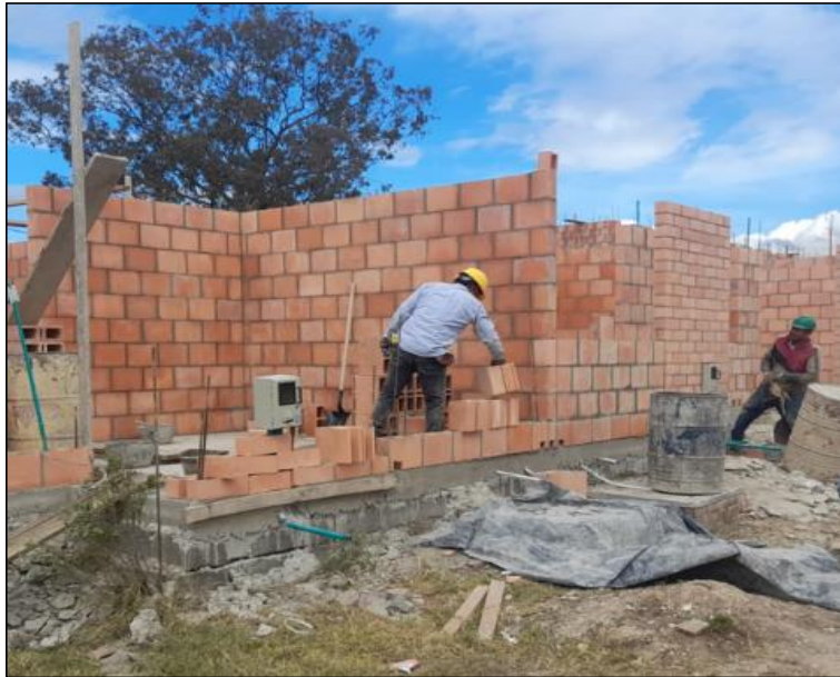
Figura 8. Muros estructurales abedules.
