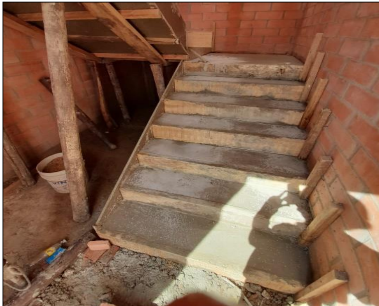
Figura 21. Escalera fundida en proceso de curado.
