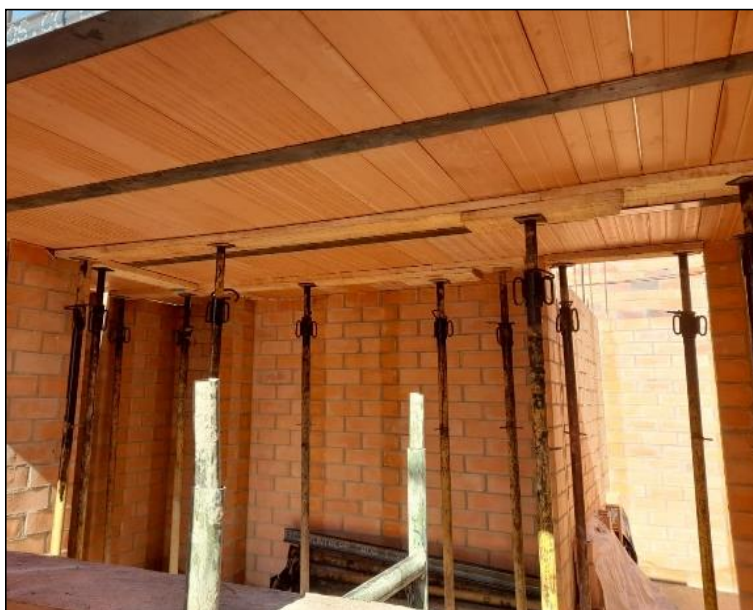
Figura 17. Instalación de parales en torres de Guadalupe y colocación de los elementos que componen la placa fácil.
