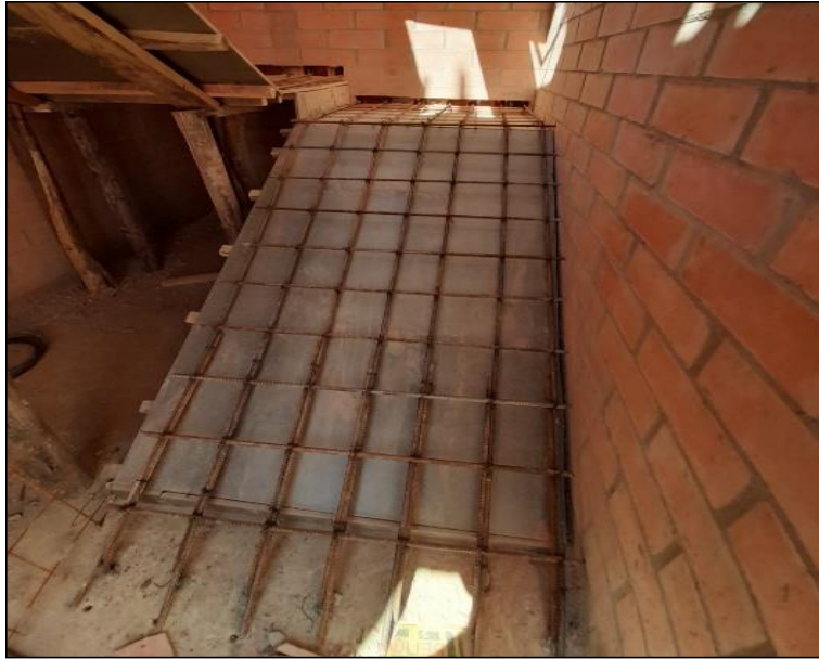
Figura 20. Colocación parrilla de refuerzo de las escaleras.
