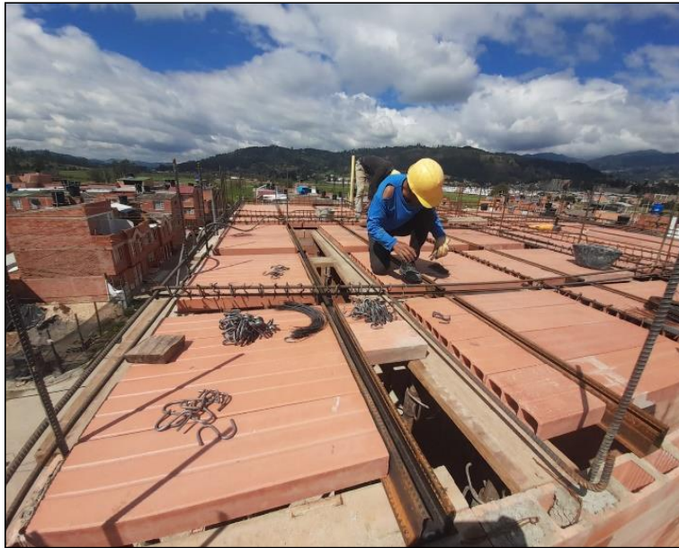
Figura 22. Elaboración armadura para la placa de cubierta.
