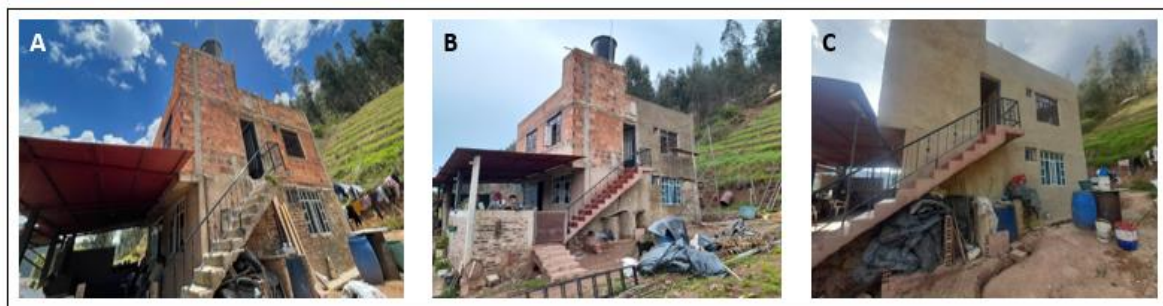
Figura 25. Proceso de mejoramiento con pañete para fachada de vivienda ubicada en la vereda Tocogua.
