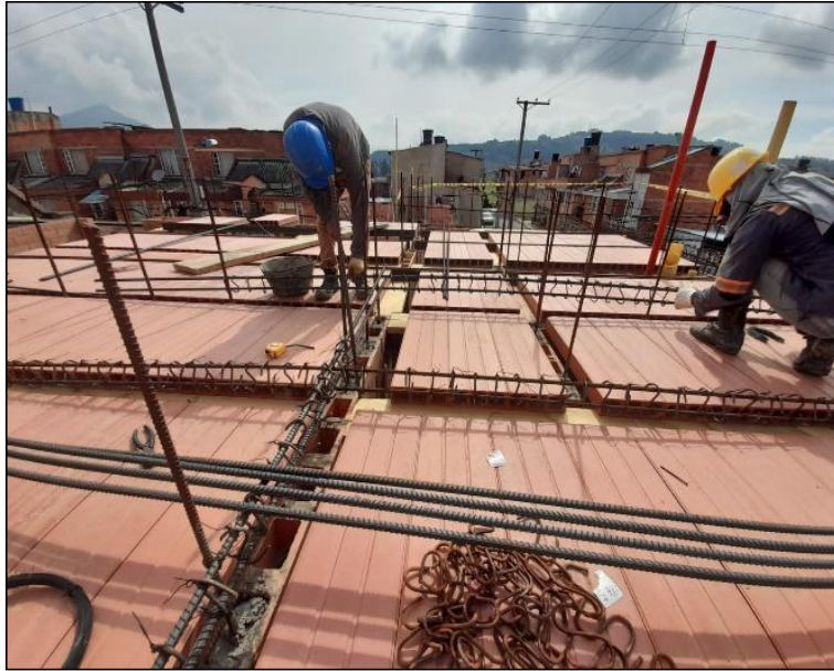
Figura 19. Elaboración de la armadura de las viguetas.
