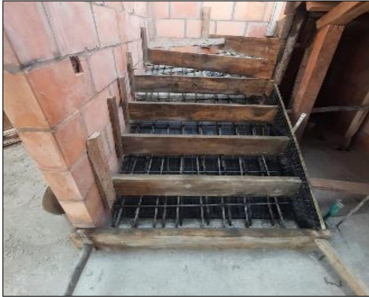
Figura 10. Encofrado escaleras casa abedules.
