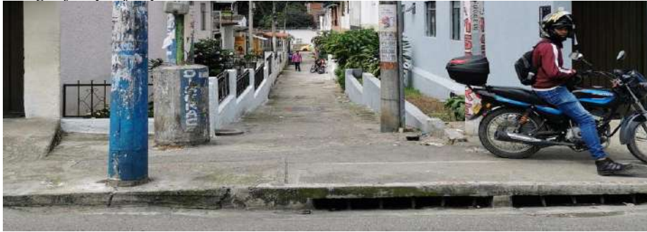
Figura 52. Fotografía perfil peatonal.
