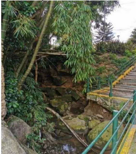
Figura 22. Fotografía zonas de pendientes pronunciadas.
