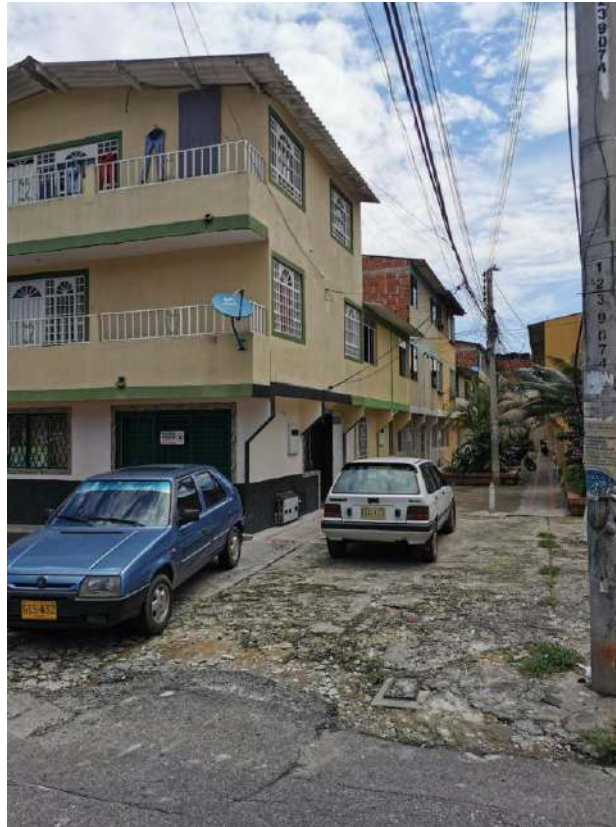
Figura 5. Estado actual andenes casco antiguo.
