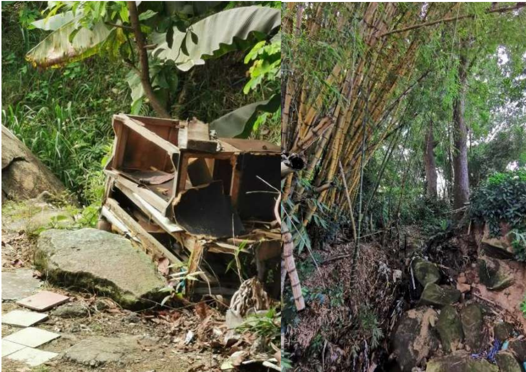
Figura 16. Fotografías estado actual del espacio público.
