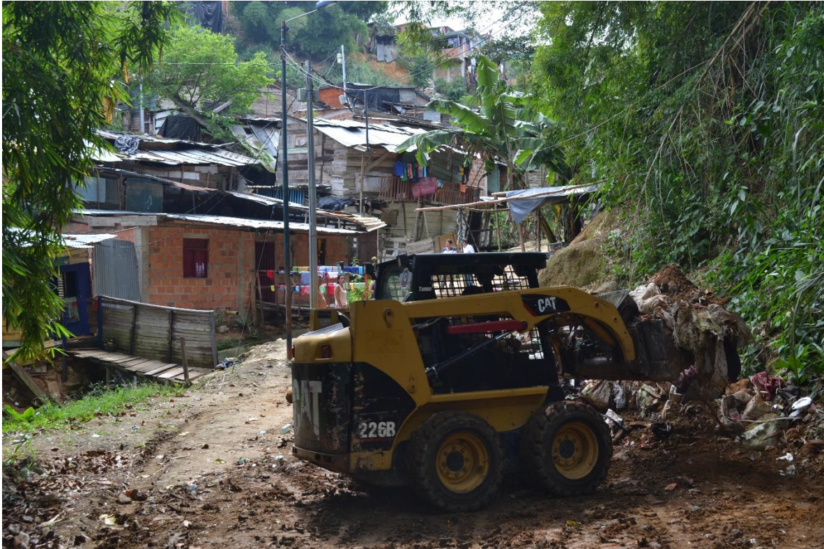
Figura 27. Materiales de fachada y cubierta. Fuente: Archivo propio
