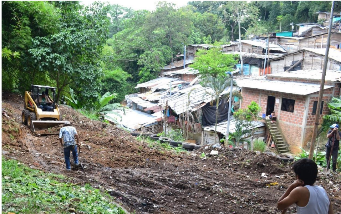
Figura 25. Materiales de fachada y cubierta. Fuente: Archivo propio.
