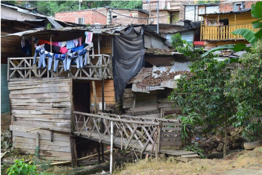
Figura 23. Materiales de fachada y cubierta. Fuente: Archivo propio.
