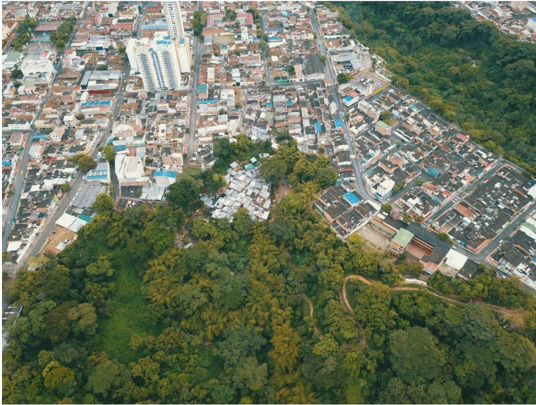
Figura 21. Localización asentamiento 12 de octubre. Fuente: INGE3D
