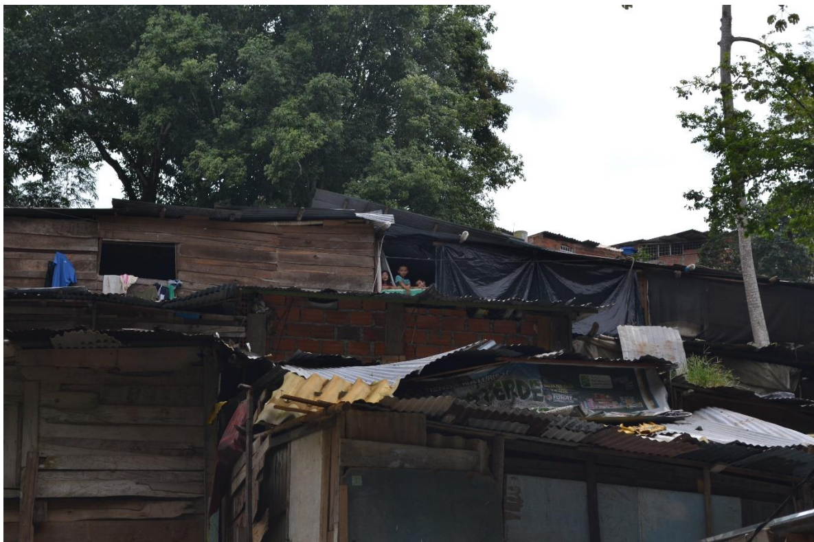
Figura 26. Materiales de fachada y cubierta. Fuente: Archivo propio.
