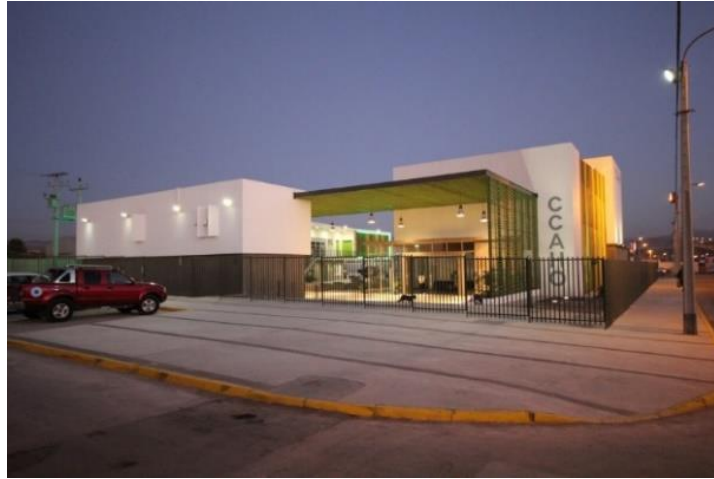
Figura 3. Fachada Centro cultural Alto Hospicio
