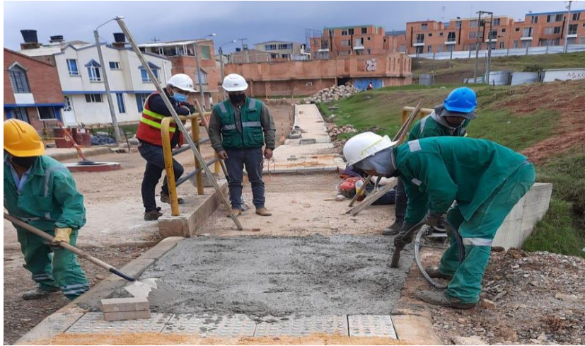
Figura 17. Instalación de concreto en obra.
