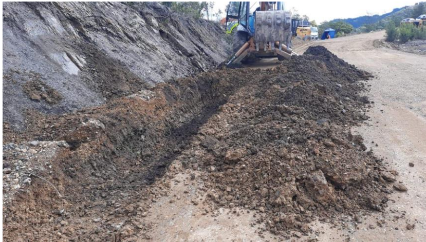
Figura 29. Cajeo para remoción de colchones.
