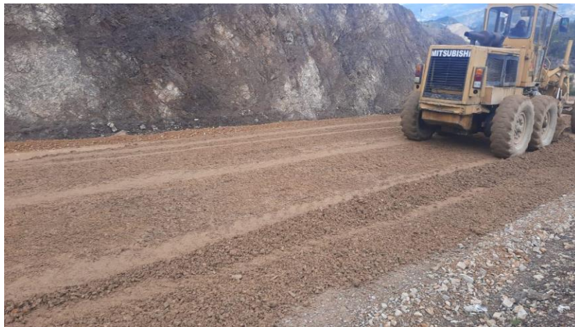
Figura 27. Céreo de subbase.
