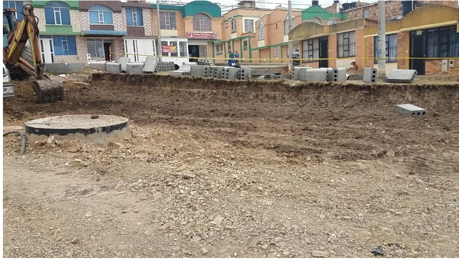
Figura 5. Excavación para adecuación de sardinel.
