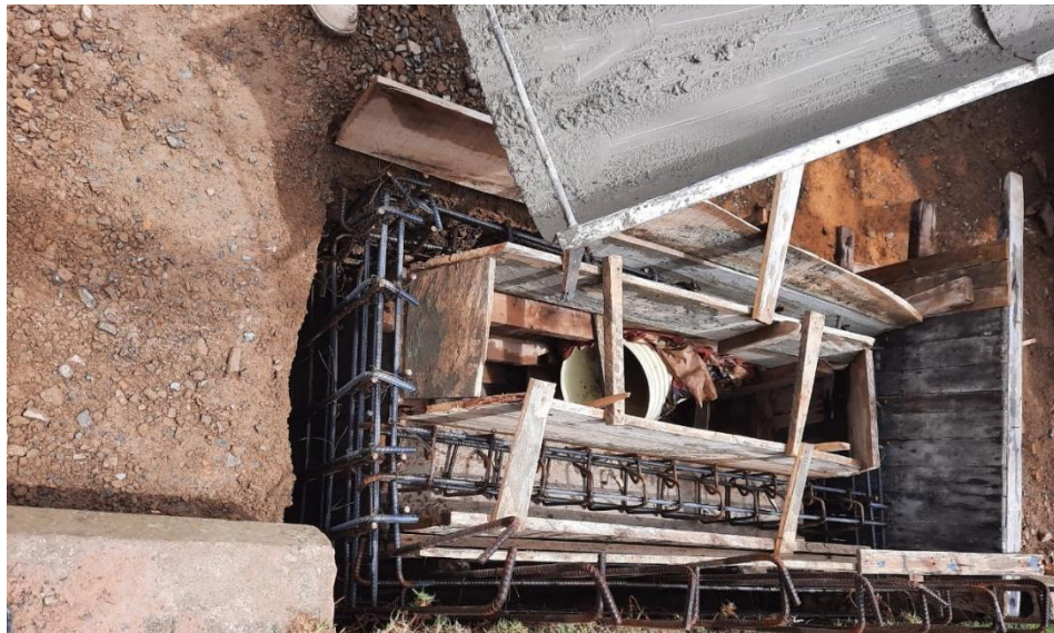
Figura 15. Fundida de sumidero tipo 1.
