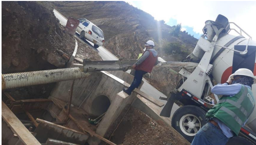
Figura 34. Construcción de dissipador de energía.
