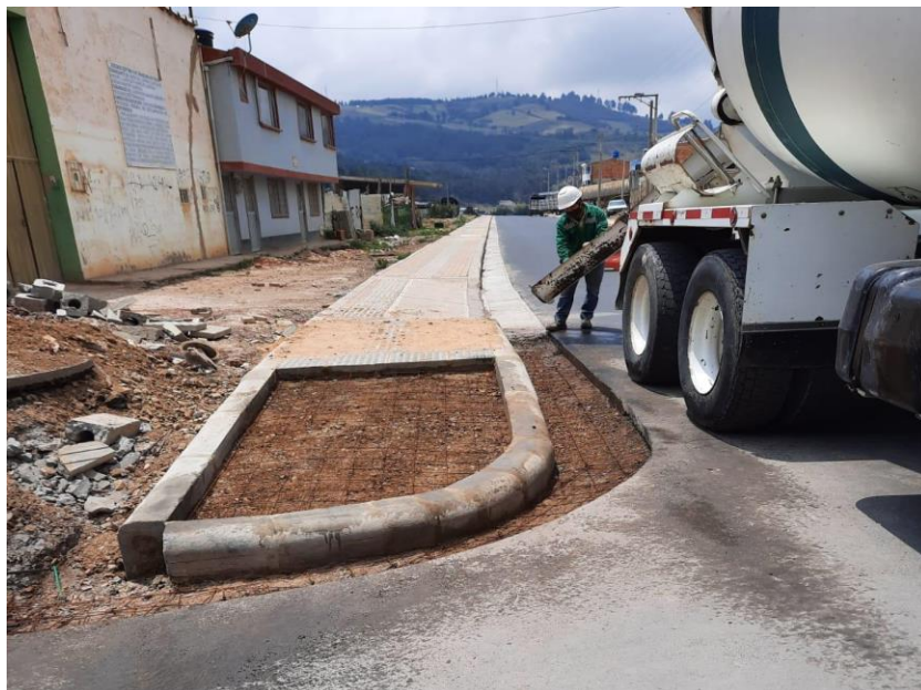
Figura 16. instalación de malla electro soldada.
