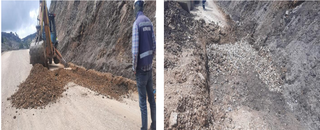
Figura 30. Cajeo para construcción de filtro.
