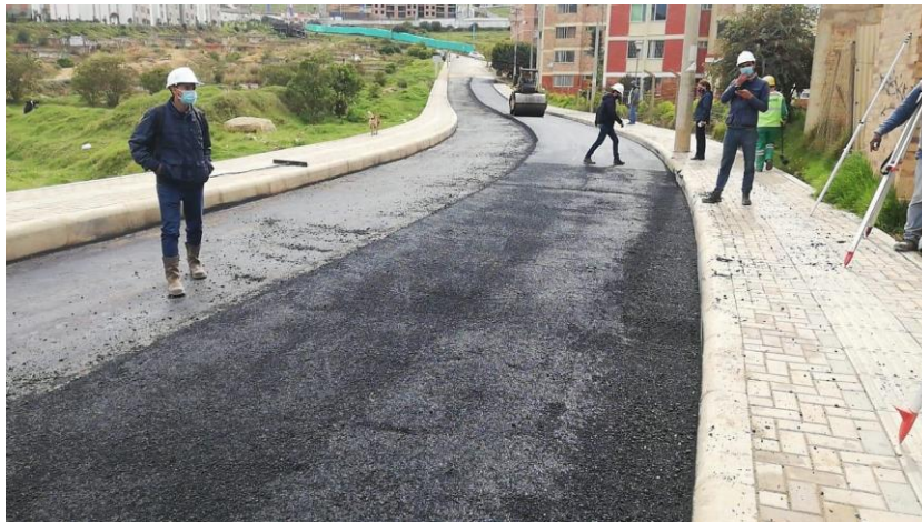
Figura 23. Compactación de carpeta asfáltica con vibro compactador.
