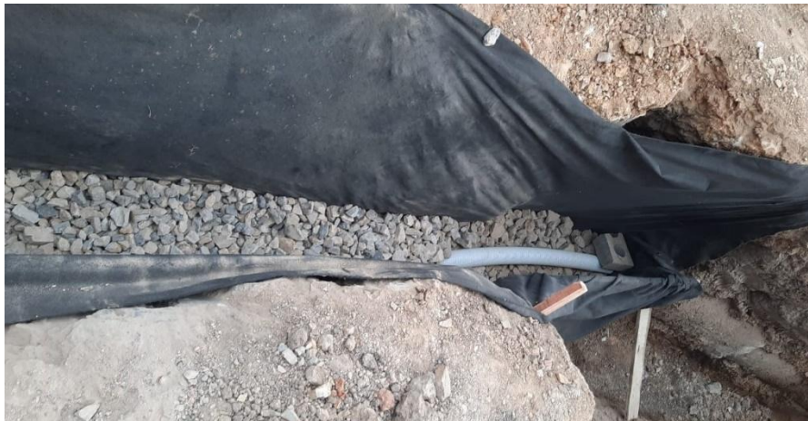
Figura 12. Construcción de filtro.
