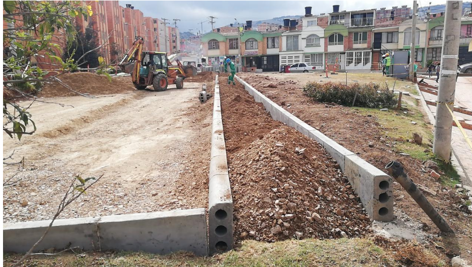
Figura 7. Relleno para andén con afirmado.
