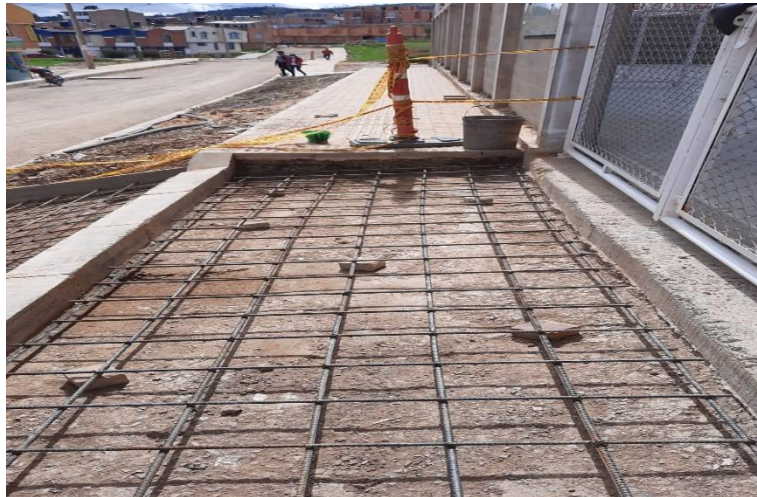
Figura 18. Amarre de acero en obra.
