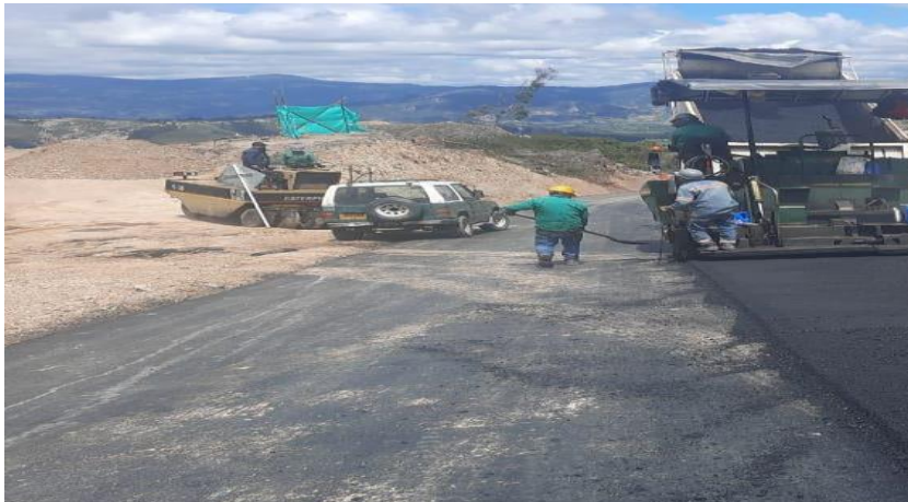
Figura 31. imprimación costado izquierdo.
