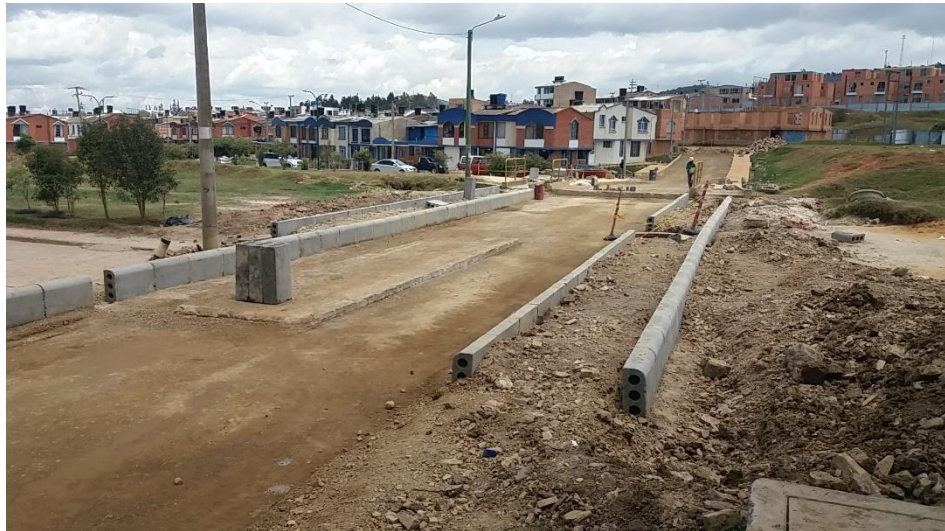
Figura 6. Instalación de Sardinel y excavación para conformación.
