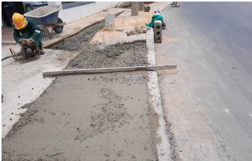
Figura 19. Instalación de concreto de 3500psi.
