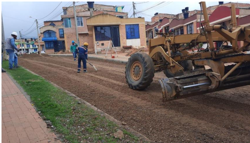
Figura 11. Instalación de base.
