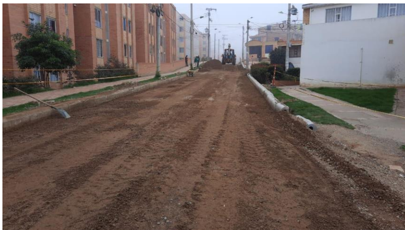
Figura 9. Instalación de subbase.
