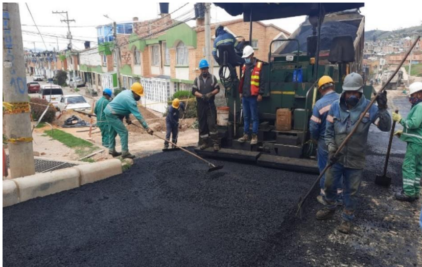
Figura 22. Extendida e instalación de carpeta asfáltica.
