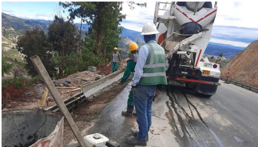
Figura 32. Construcción de cunetas.
