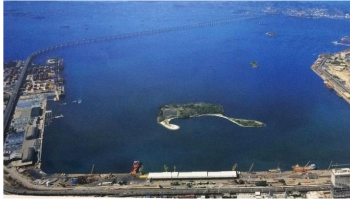
Figura 9. Panorámica Puerto Rio de Janeiro
