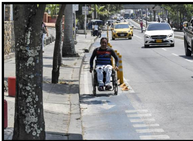
Figura 2. Estado de andenes ciudad de Cali
