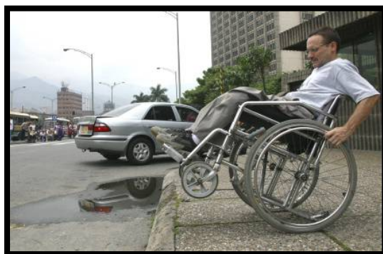
Figura 1. Estado andenes ciudad de Medellín
