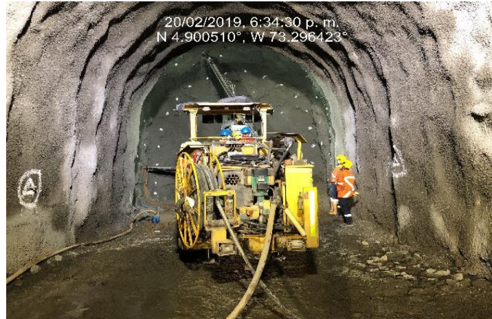
Ilustración 34 Perforación para Voladura con Jumbo (Autor: Fuente Propia)
