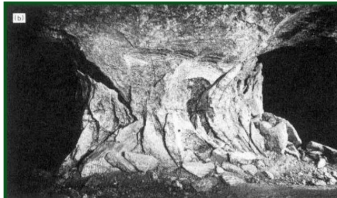
Ilustración 30 fenómeno Creep (Marulanda, 2018)
