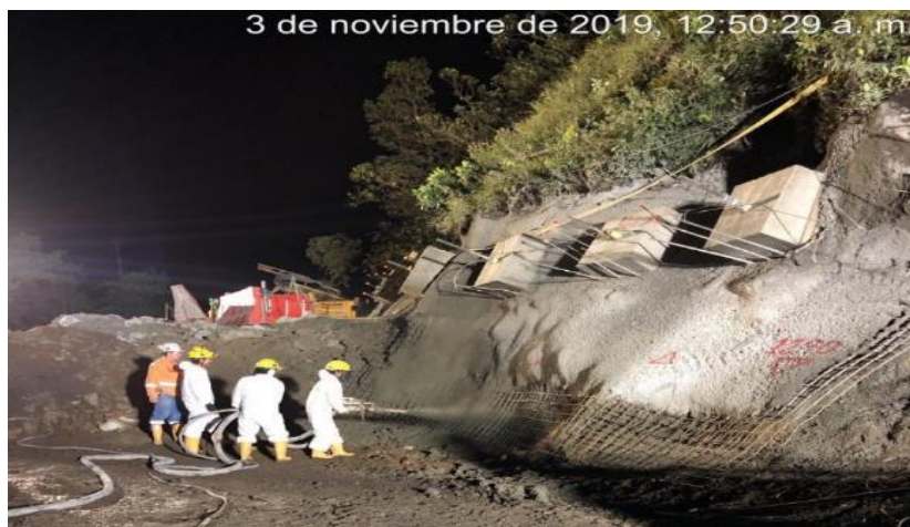
Ilustración 20 Proyección manual de hormigón (Autor: Fuente Propia)
