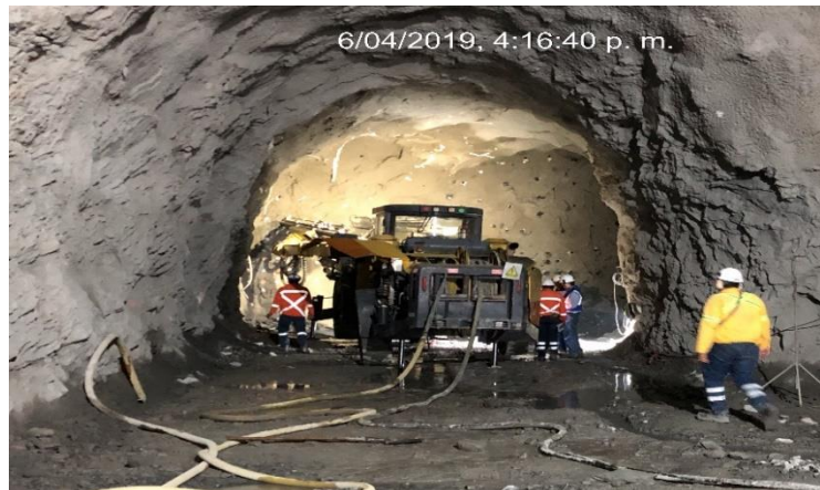
Ilustración 23 Perforación para voladura (Autor: Fuente propia)
