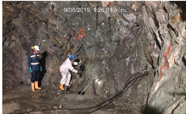
Ilustración 38 Frente posteriormente a la inyección (Autor: Fuente Propia)
