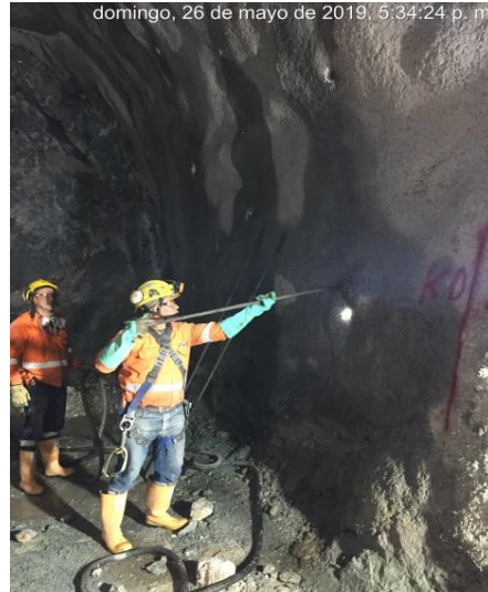
Ilustración 32 Instalación de pernos (Autor: Fuente Propia)
