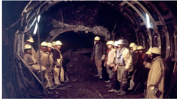
Ilustración 5 Túnel Palacio Rioblanco tramos afectados por derrumbes (Marulanda, 2014)
