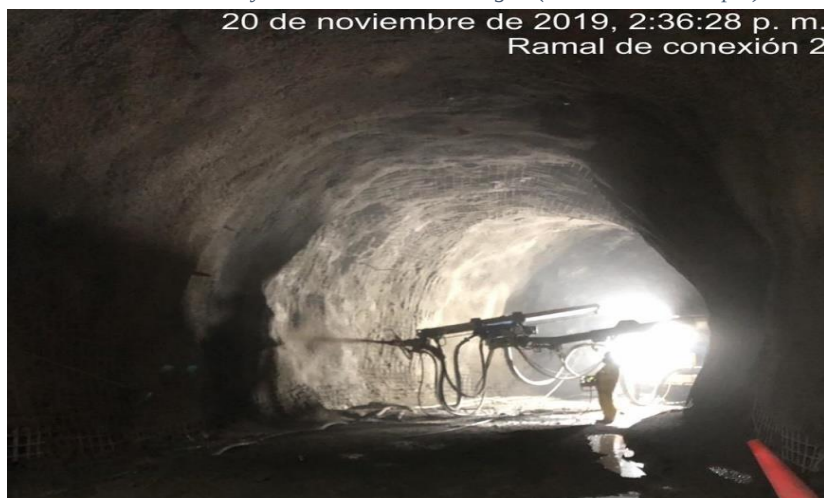
Ilustración 21 Proyección robótica de hormigón (Autor: Fuente Propia)
