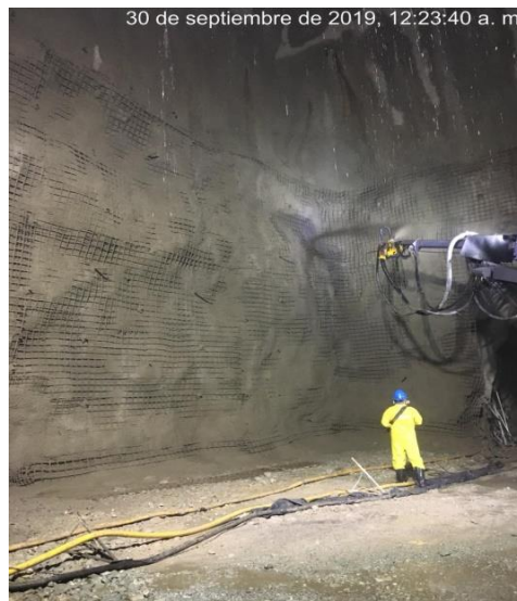
Ilustración 25 Hormigón proyectado como revestimiento definitivo (Autor Propio)
