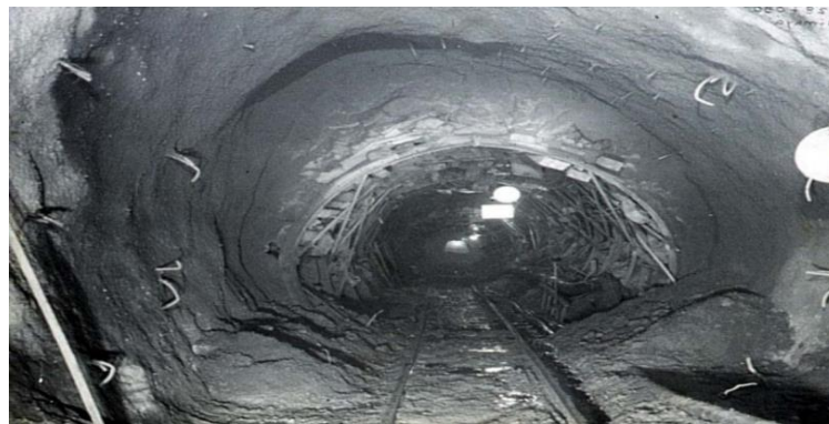
Ilustración 6 Rehabilitación túnel Palacio Rioblanco (Marulanda, 2014)
