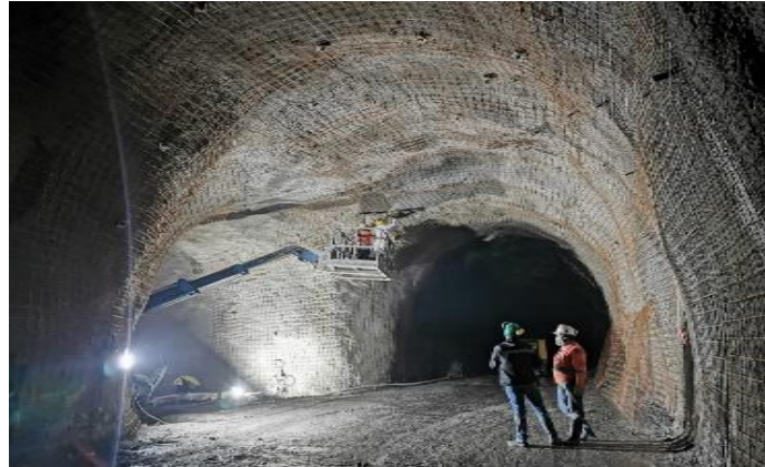
Ilustración 40 Instalación de malla electrosoldada (Autor: Fuente Propia)
