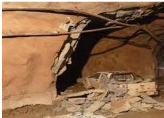
Ilustración 29 Estallido de roca (Marulanda, 2018)
