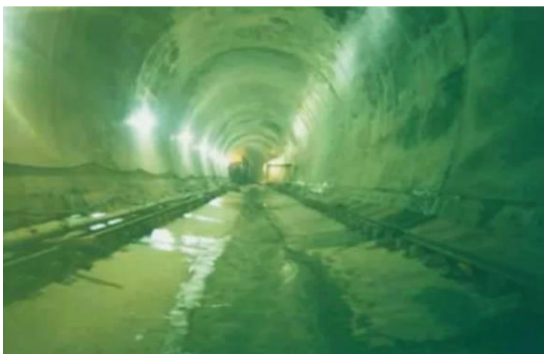
Ilustración 12 Hidroeléctrica Urra 1 Túnel No 2 (Silva, 2015)
