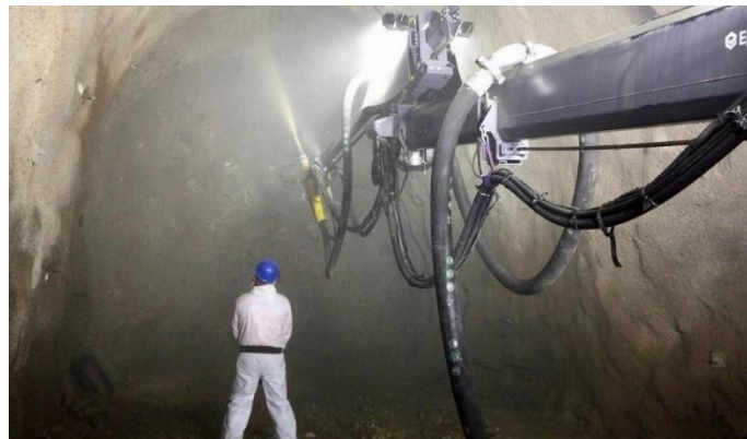
Ilustración 33 Hormigón Proyectado para sostenimiento (Autor: Fuente Propia)
