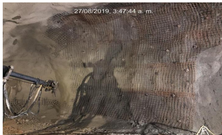
Ilustración 41 Hormigón proyectado de revestimiento (Autor: Fuente Propia)
