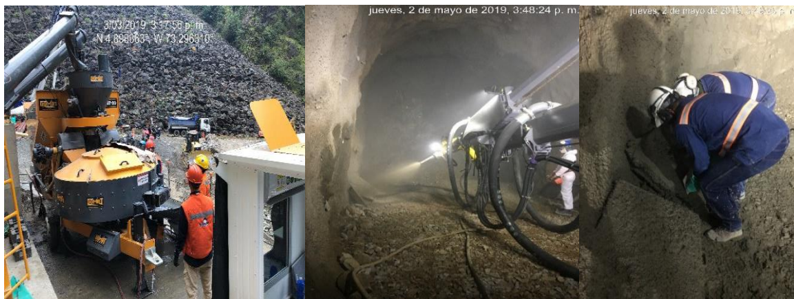
Ilustración 45 Pruebas a nivel industrial de hormigón proyectado (Autor: Fuente Propia)
