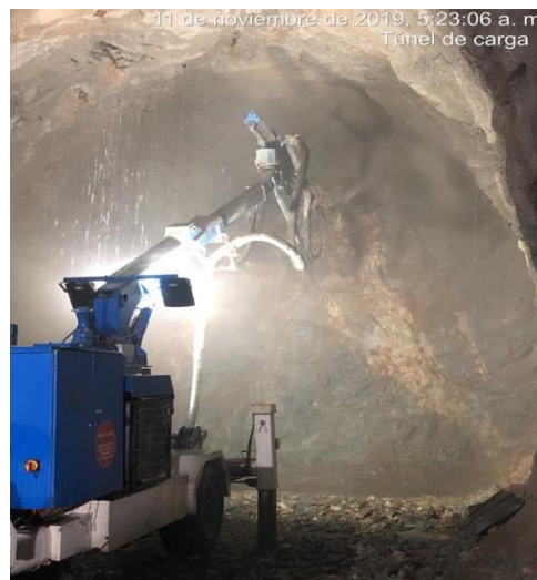
Ilustración 24 Hormigón proyectado tratamiento para soporte (Autor: Fuente propia)
