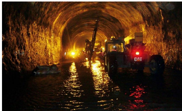
Ilustración 7 Túnel de fuga - Hidroeléctrica Del Guavio (Marulanda, 2014)
