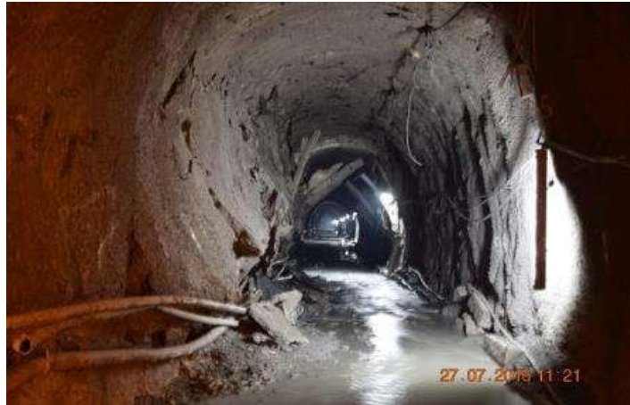
Ilustración 28 Falla Swellin en un túnel (Marulanda, 2018)
