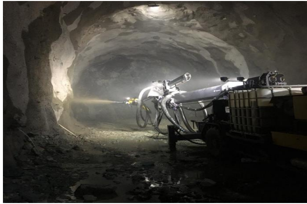
Ilustración 36 hormigón proyectado capa primaria (Autor: Fuente Propia)
