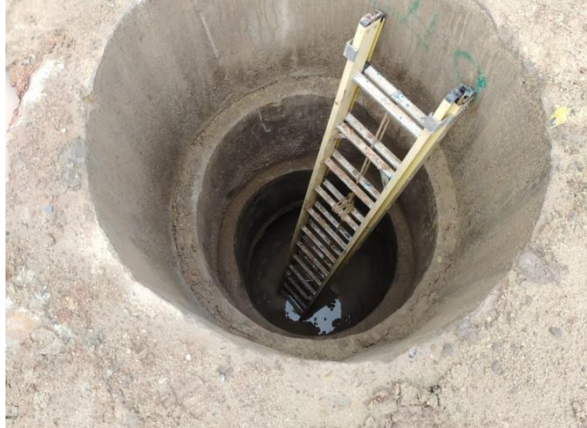
Figura 22. Verificación profundidades caisson.
