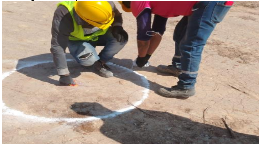
Figura 20. Replanteo de caisson antes de la excavación.
