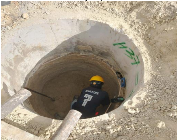
Figura 38. Excavación manual de caisson y exposición de la formación geológica Tilatá.
