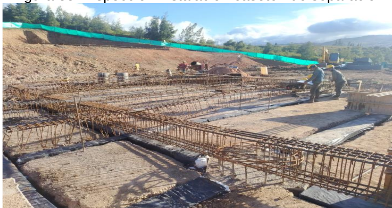
Figura 35. Inspección instalación casetón de separación.
