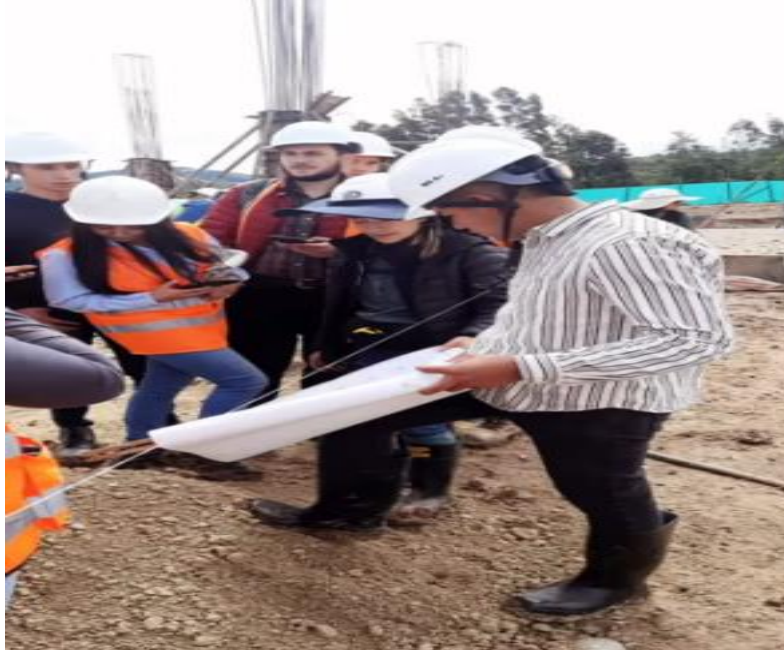
Figura 40. Exposición técnica sobre cimentación profunda.
