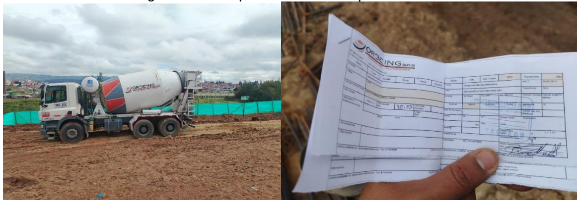
Figura 30. Recepción de concreto premezclado.
