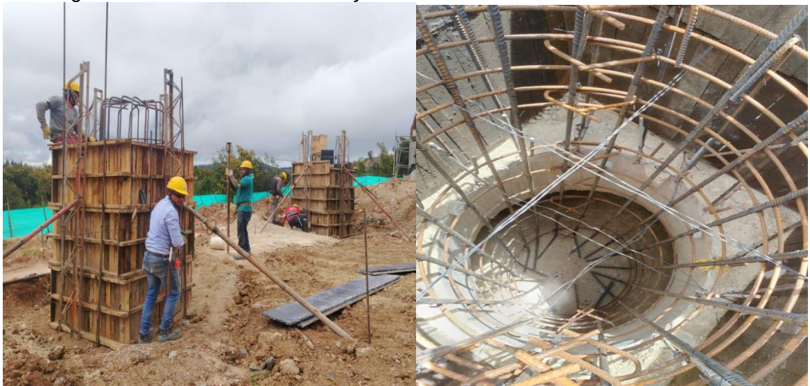
Figura 23. Nivelación de caisson y verificación del encofrado antes del vaciado.
