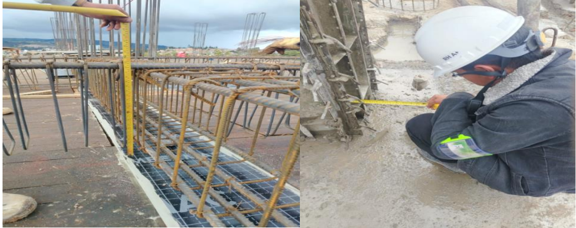
Figura 24. Verificación del armado de acero y plomos en elementos verticales
