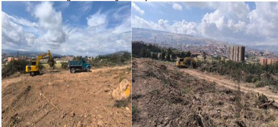
Figura 10. Configuración y nivelación del terreno.
