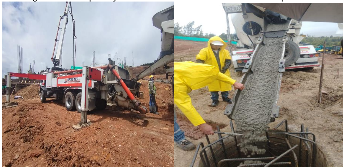
Figura 26. Recepción y vaciado de concreto en cimentación bloque central
