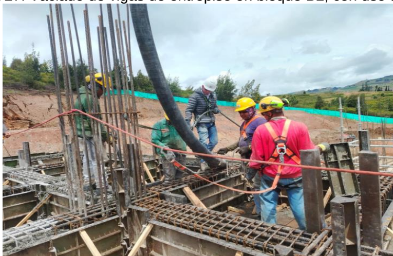
Figura 27. Vaciado de vigas de entrepiso en bloque B2, con uso de EPP.
