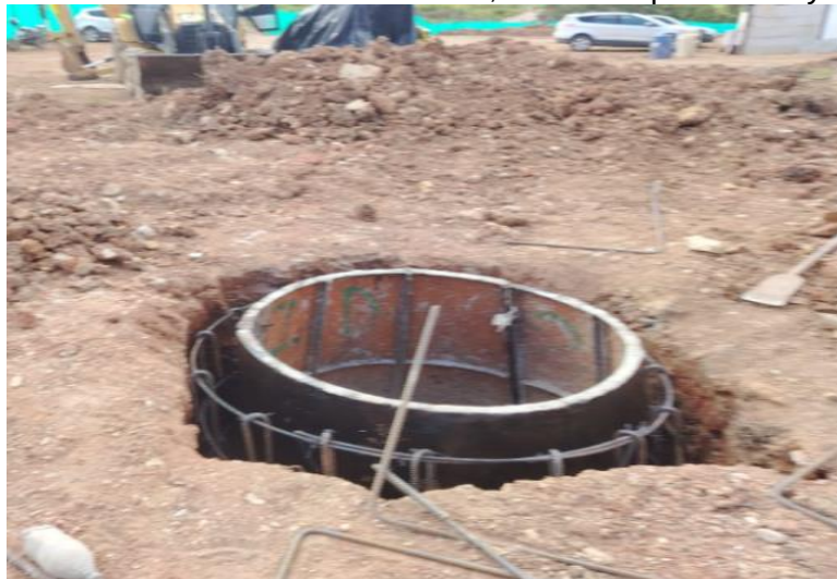
Figura 21. Instalación del acero de refuerzo, anillos de protección y encofrado.
