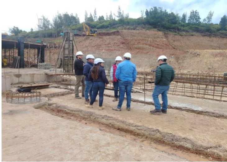
Figura 37. Visita supervisión técnica en obra.
