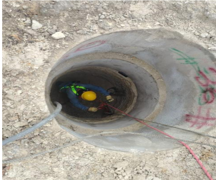
Figura 39. Excavación mecánica de caisson.
