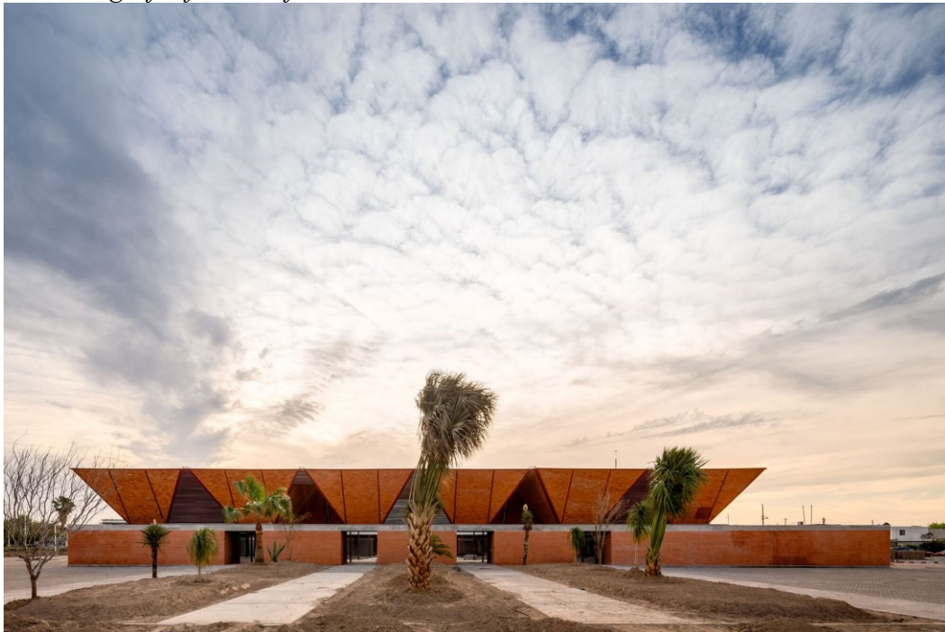
Figura 13. Fotografía fachada frontal
