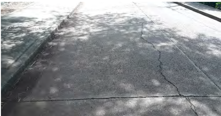
Imagen No. 111L. Grieta longitudinal ocasionada por hundimiento de la placa hacia el costado izquierdo de la lesión. Se prolonga en placas aledañas .
