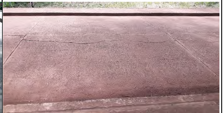
Imagen No. 111T. Se evidencia un hundimiento hacia el borde izquierdo de la placa.
