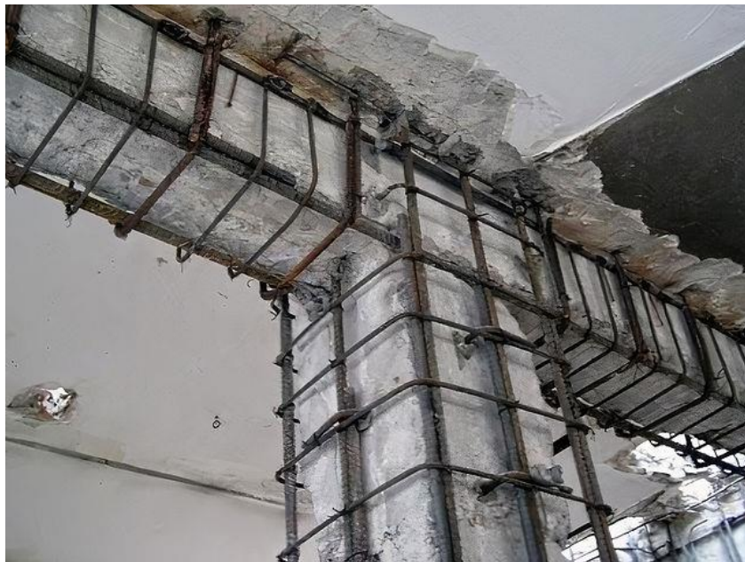
Imagen 59. Refuerzo estructural. Fuente: Preserva Ingeniería y Construcción
