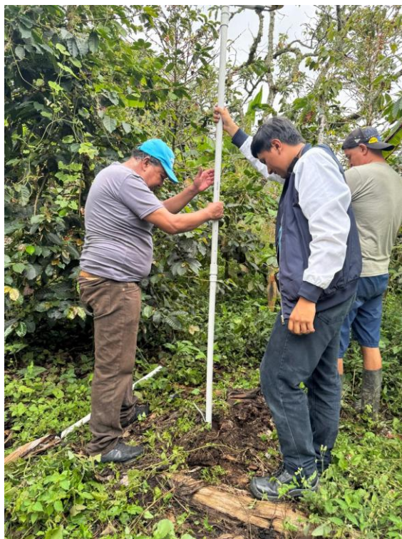
Ilustración 58 - Instalación módulo de sensores - parte 2 Fuente: autoría propia
