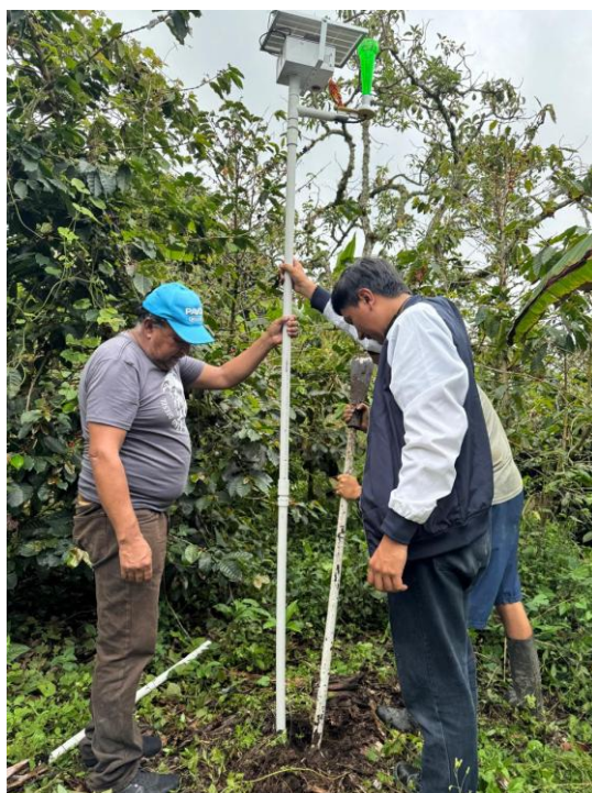
Ilustración 57 - Instalación módulo de sensores - Parte 1 Fuente: autoría propia
