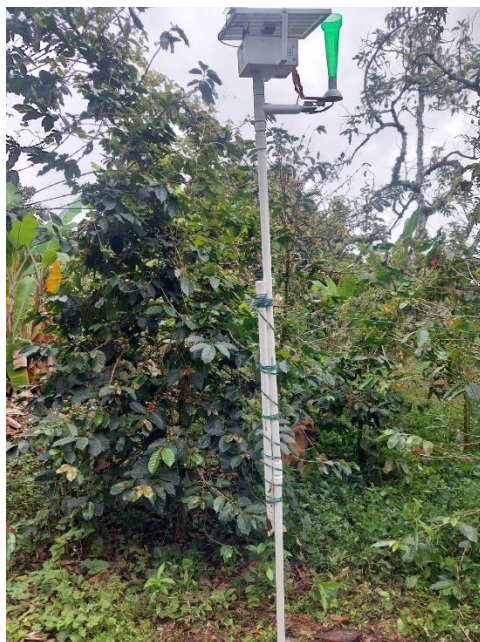
Ilustración 60 - Instalación del módulo de sensores - Colocación final Fuente: autoría propia
