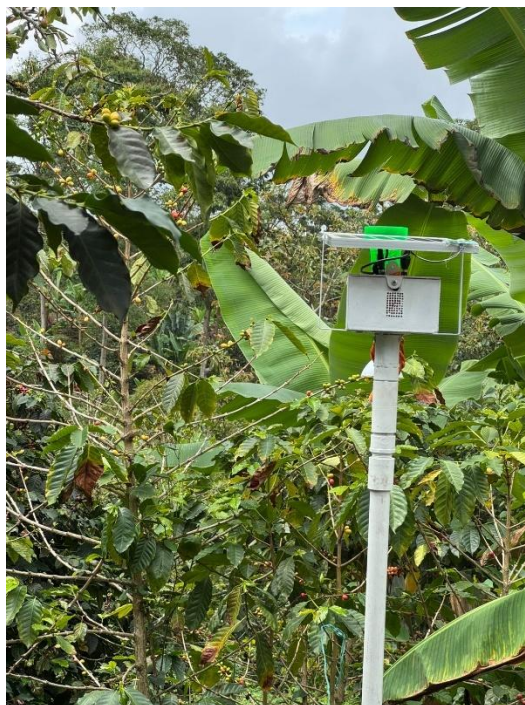
Ilustración 62 - Colocación final 2 - Módulo de sensores Fuente: autoría propia
