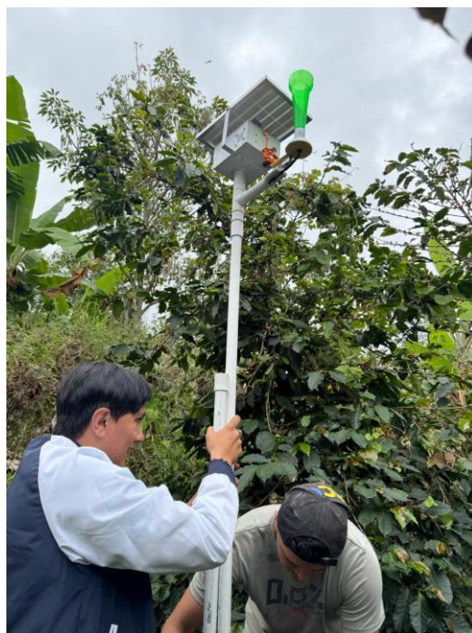
Ilustración 59 - Instalación del módulo de sensores - parte 3 Fuente: autoría propia
