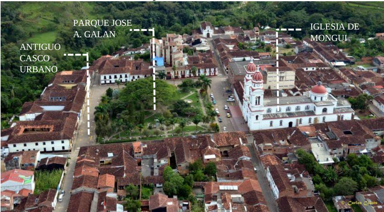
Figura 8 Vista aérea localizadora del Centro Histórico. Tomada por Carlos Cortes, rescatada de http://charalagrande.com/la-ejecucion-del-plan-maestro-de-acueducto-y-alcantarillado-de-charala-sigue-en-riesgo/
