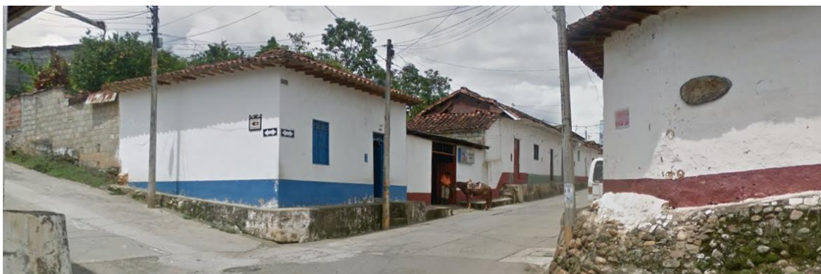
Figura 30 Fotografía de la esquina de la manzana del lote 2. (s.f). Google maps, 2016
