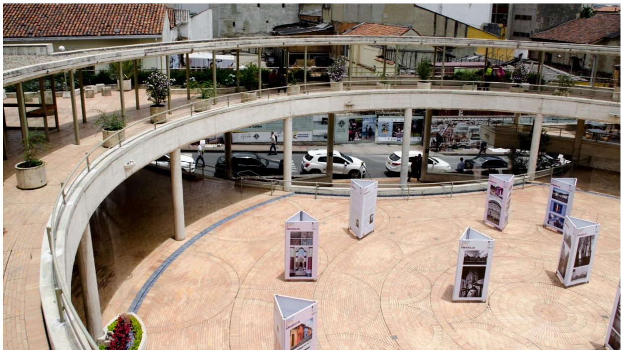
Figura 64 vista de la fachada permeable del centro cultural
