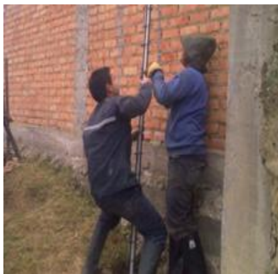
Figura 85. Instalación de Tubería Fija
