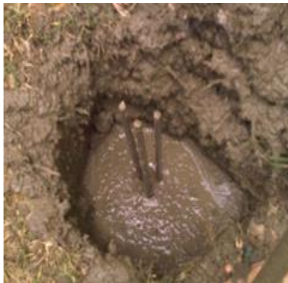
Figura 89. Inyección del Cemento
