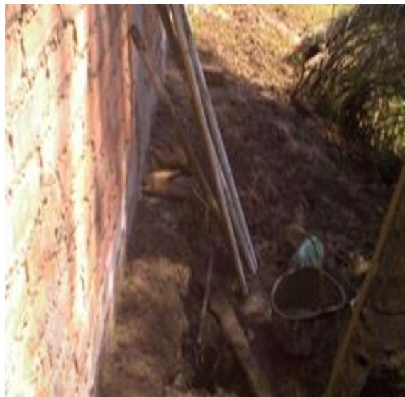
Figura 88. Compactación del Cemento
