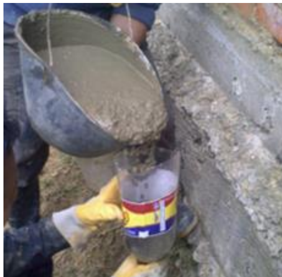
Figura 87. Recubrimiento de la Tubería
