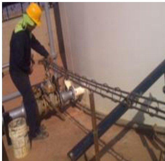
Figura 84. Micropilotes
