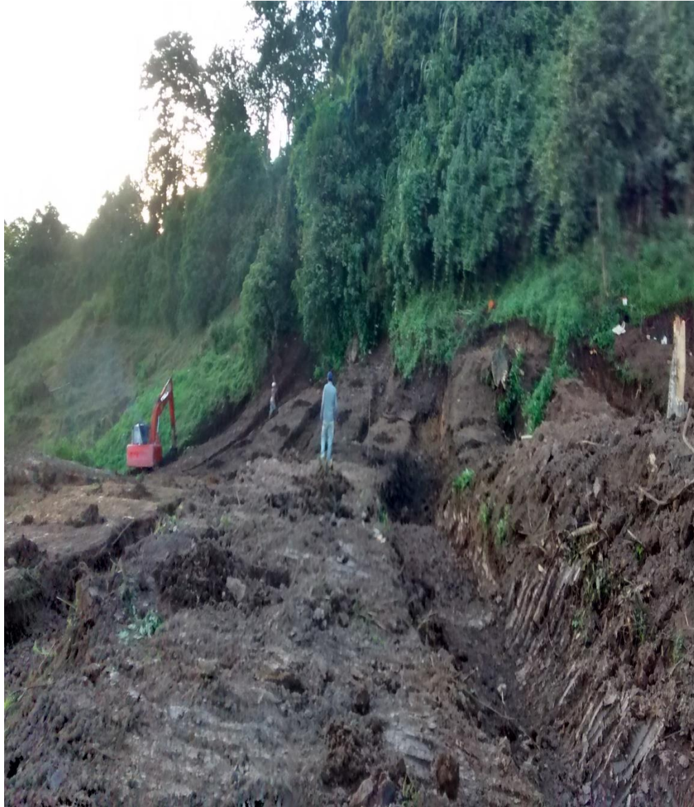
Construcción de Camellones
