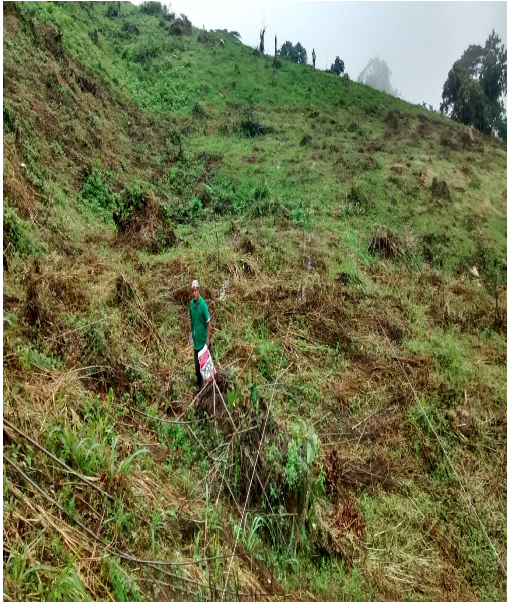
Demarcación de terreno para la construcción de los camellones
