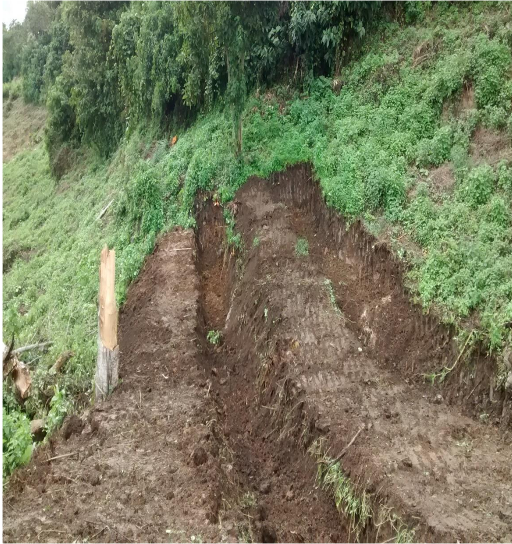
Construcción de Camellón.
