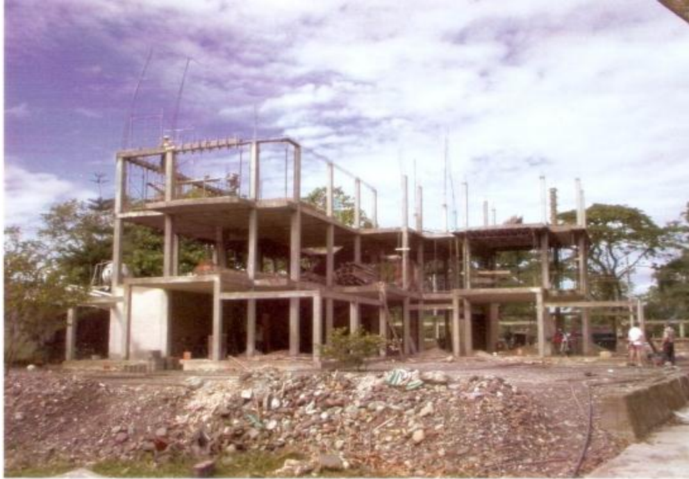
Foto No. 37 Levantamiento pórticos en concreto reforzado
