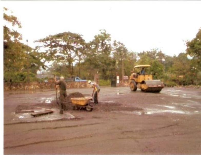
Foto 50 : Relleno estructural
