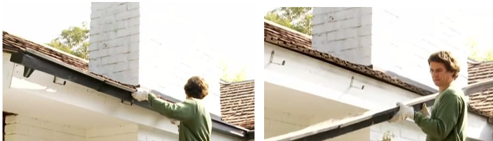
Grafico 58 Fotografía desinstalación de viga canal.
