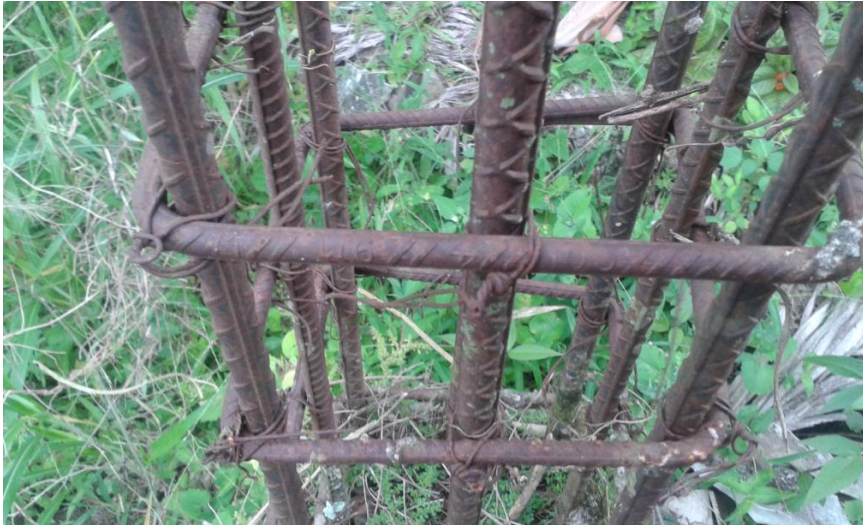
Foto No. 47: Levantamiento de una de las columnas
