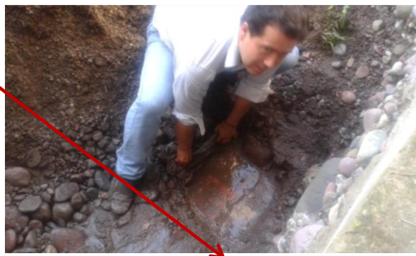
Fotos 54 y 55 : Piso de cerámica en fondo del relleno
