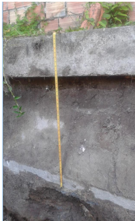
Foto 48: Elemento de confinamiento perimetral.
