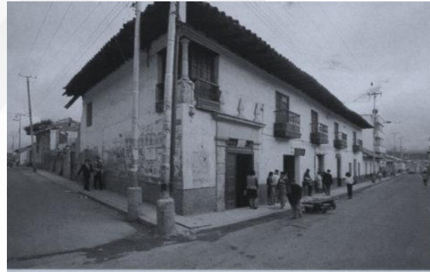
Figure 2 construcción en deterioro tomada de(propia)
