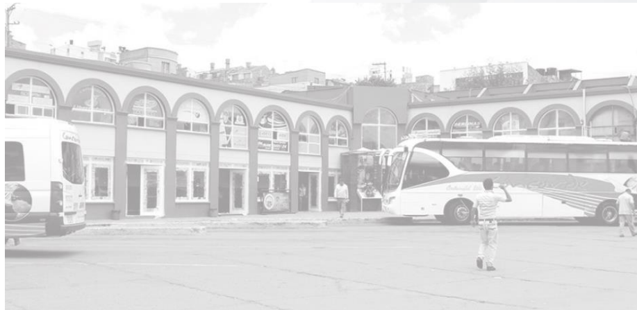
Figure 11 FACHADA DEL TERMINAL DE TRANSPORTES, FUENTE: MARIA JOSE CHOCONTÁ MARTÍNEZ
