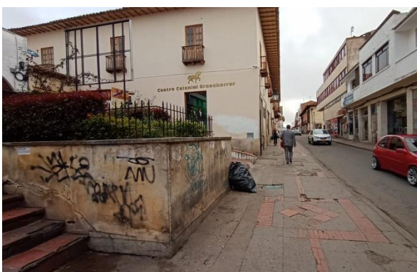
Ilustración 32 Centro Bancario Gran Ahorrar - 7:00am 07-2022 – Fuente: Propia
