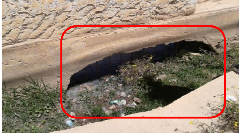
Fotografía 5. Alcantarilla 1: K0+786 metros.
