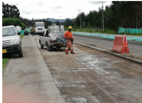
Figura 2. Humectación de capas granulares Source: Autor
