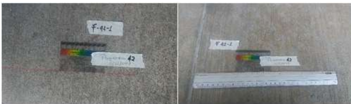
Figura 14. Colocación de a fisurómetros. Por Bueno Agudelo, Y. P. y Padilla Pacheco, Y. V. (2018). Localización e identificación de fisurómetros sobre losa de parqueadero a nivel en puesto de parqueo 42. Estudio Patológico Edificio de Parqueadero Conjunto Residencial Altos del Parque, Cali- Valle . Universidad Santo Tomás. Bogotá, Colombia.
