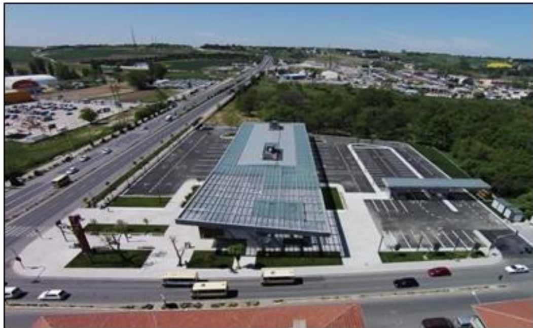
Figura 29. Estación de Autobuses Lüleburgaz.
