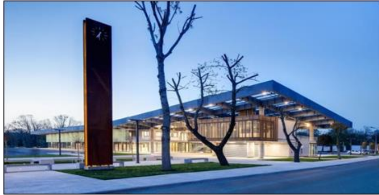
Figura 30. Estación de Autobuses Lüleburgaz.
