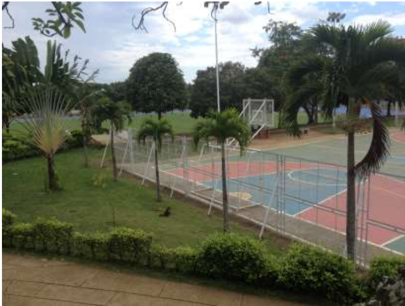
Figura 121. F4 estado actual
