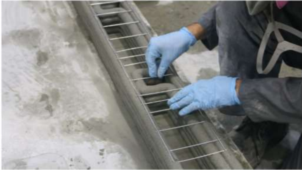
Figura 82. Refuerzo en muro de modulo constructivo Adaptado: Constructora Conconcreto
