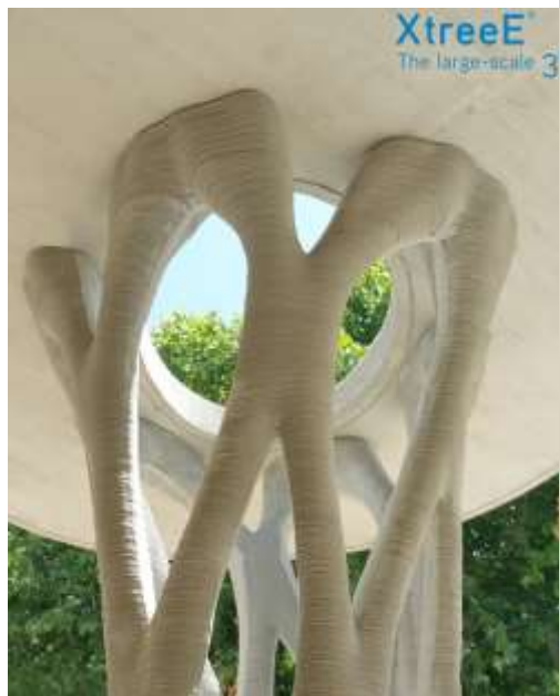
Figura 57. Columna impresa en 3D una vez retiradas las balsas de soporte Adaptado: Archdaily, 2020
