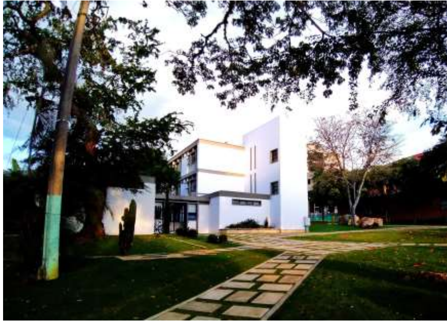
Figura 119. F2 estado actual
