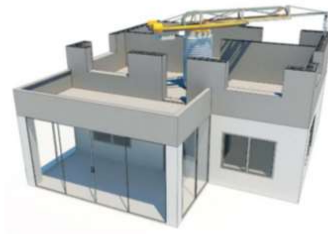
Figura 50. Continuidad de impresión Adaptado: Apis Cor
