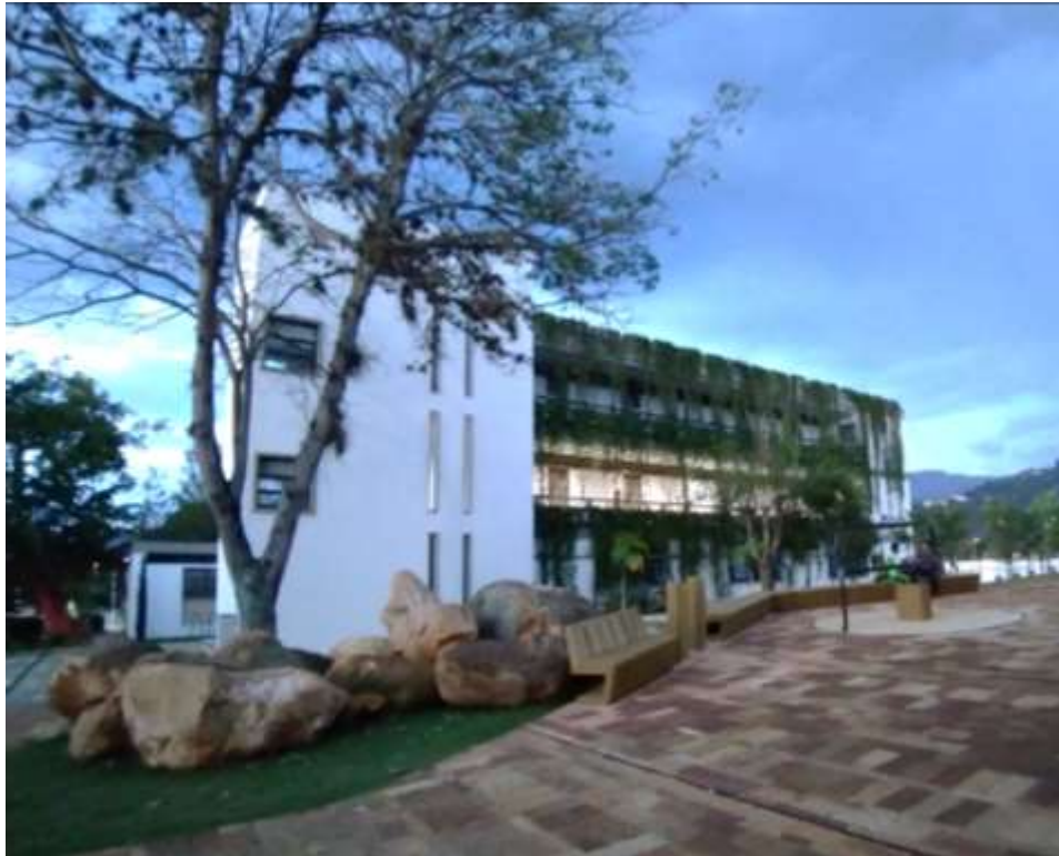
Figura 141. Residencias universitarias UIS estado actual
