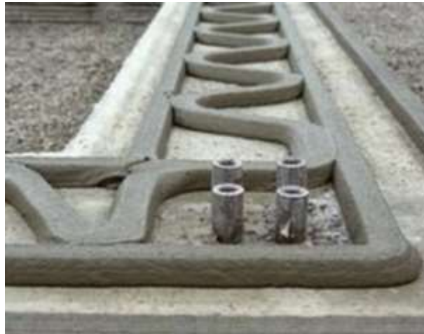
Figura 42. Conectores férricos estructurales Adaptado: Apiscor3d, Instagram, 2017
