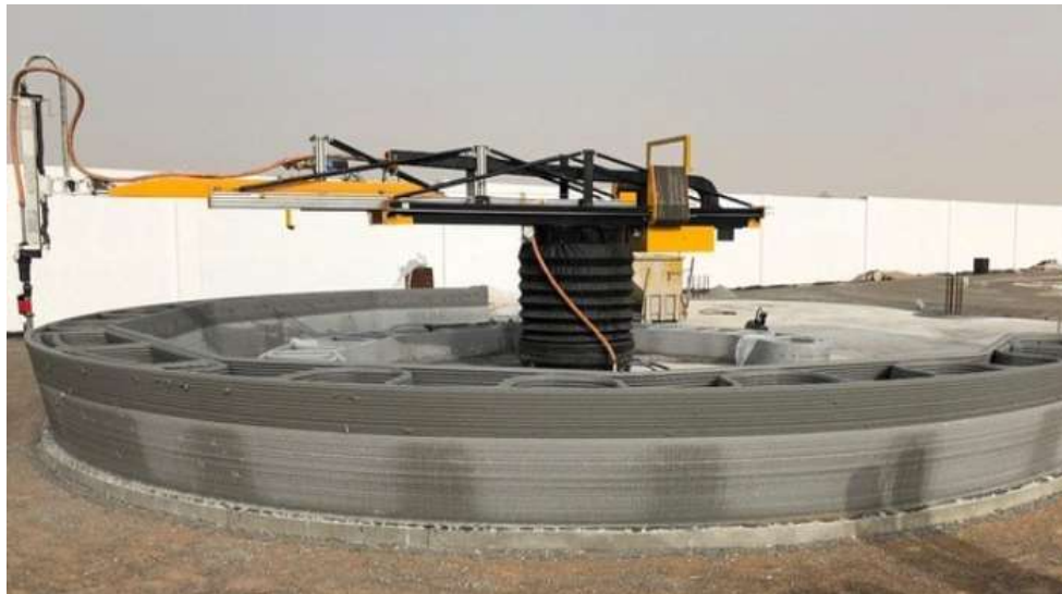
Figura 59. Impresión muro inclinado Adaptado: apiscor3d, Instagram, 2020
