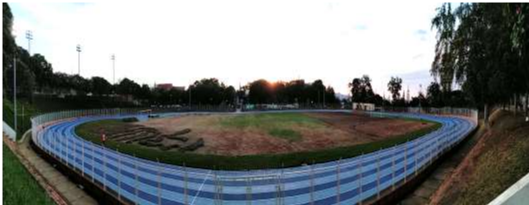
Figura 124. F7 estado actual
