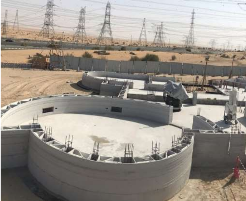
Figura 48. Refuerzos verticales Adaptado: Apiscor3d, Instagram, 2020
