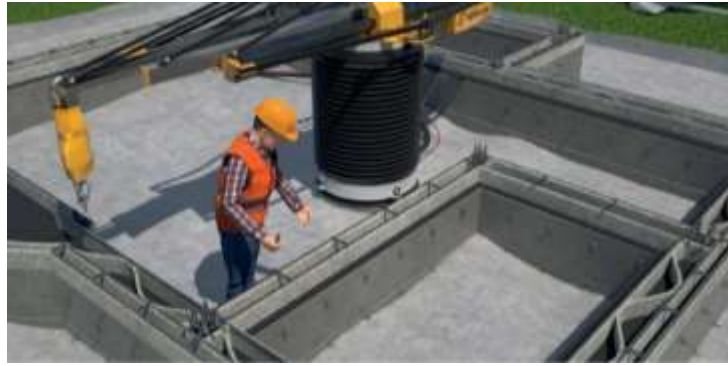
Figura 43. Levantamiento de Muros Adaptado: Apis Cor
