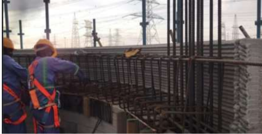
Figura 39. Encofrado de viga e instalación Adaptado: Apiscor3d, Instagram, 2020
