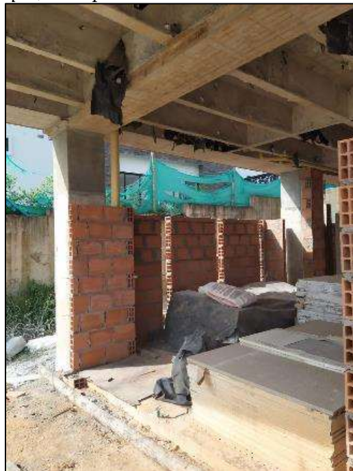
Figura 12. Casa 65 Punta Ruitoque, Mampostería Nivel -1
