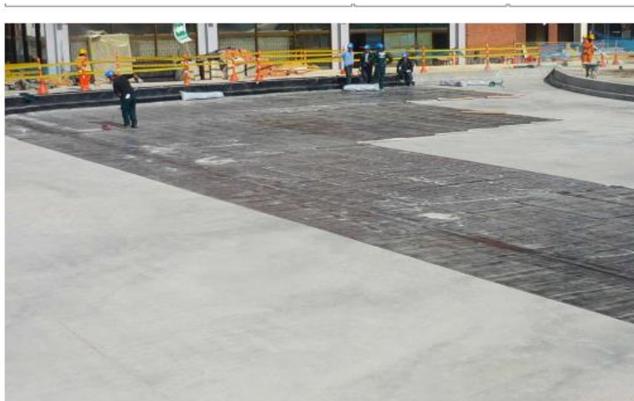
Imagen 22 instalación membrana Paraseal STD Fuente (fabricante Toxement)
