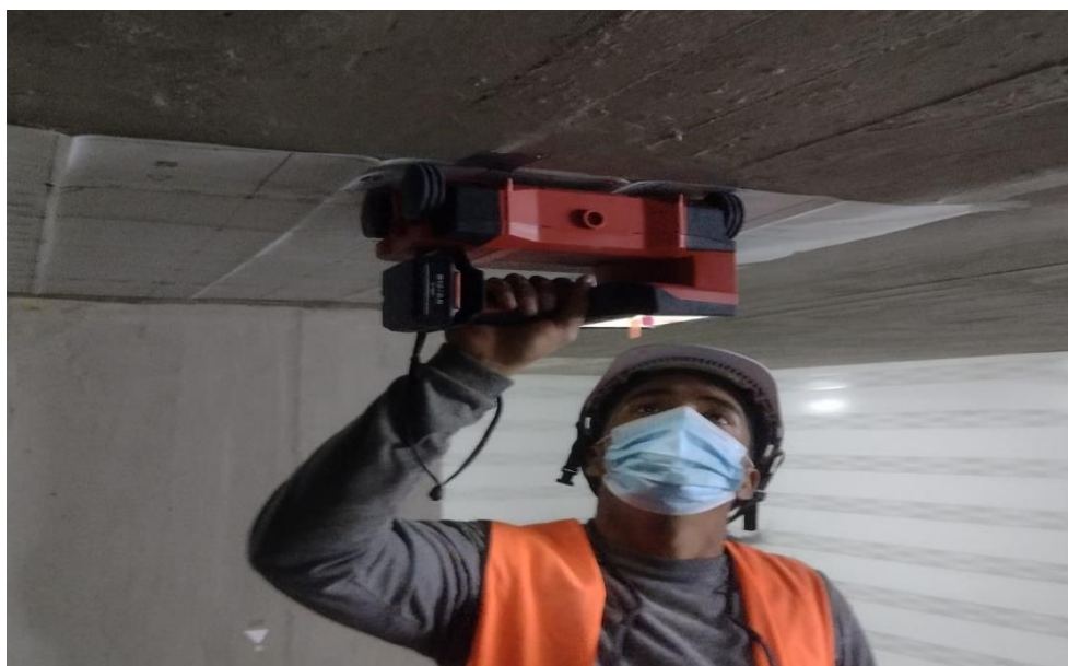
Figura 34. Toma de imagen con Ferroskan Hilti pc200
