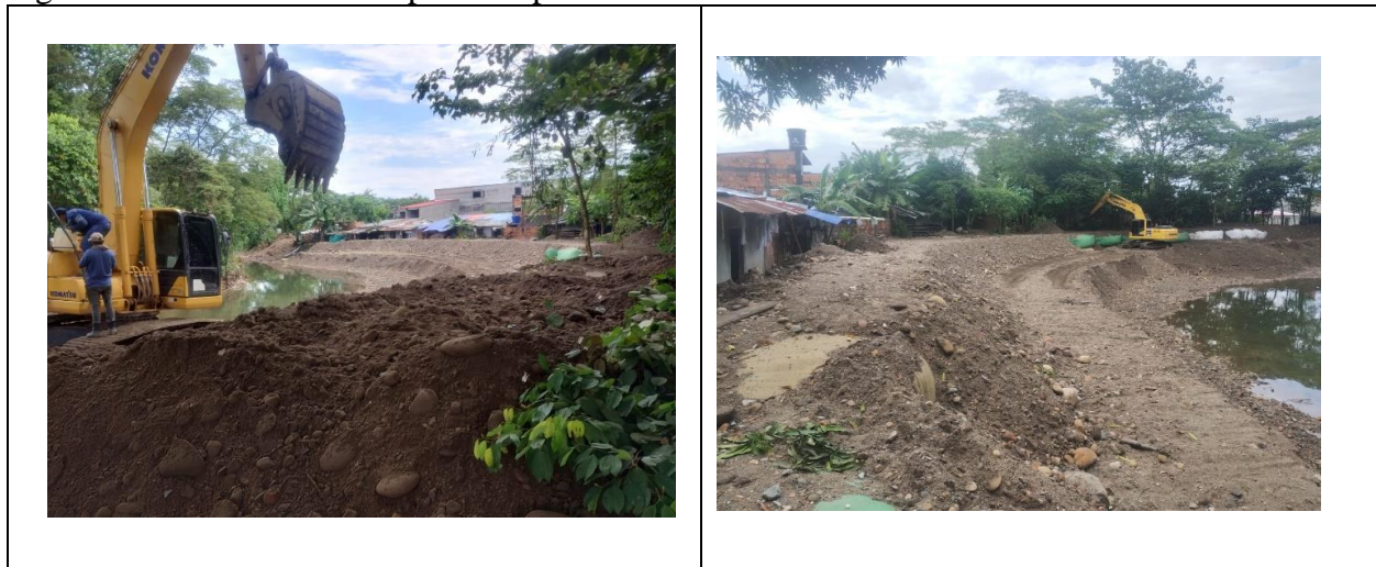
Figura 3 Sector del Rubí después del proceso de canalización
