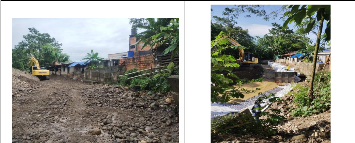
Figura 2 Sector del Rubí antes del proceso de canalización
