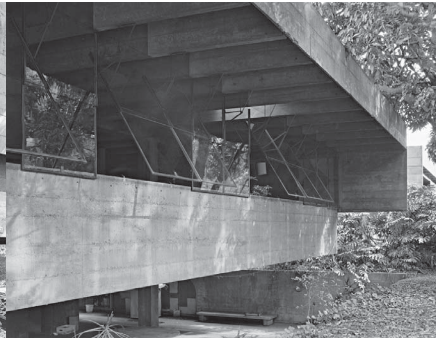
Imagen 57. Casa Butanta Cubierta.
