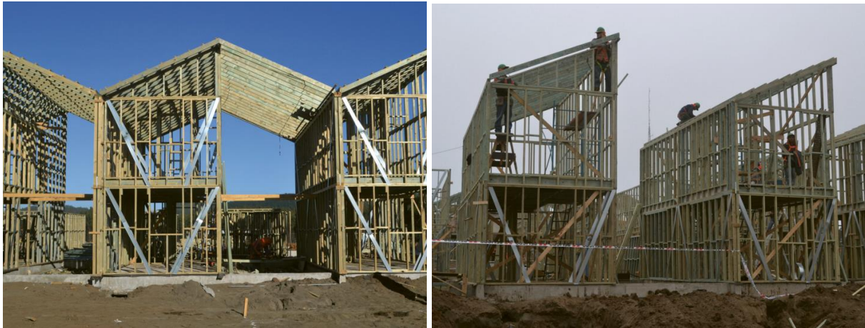
Figura 6. Imágenes de cómo fue construida. Fuente: “academic.arch.”.
