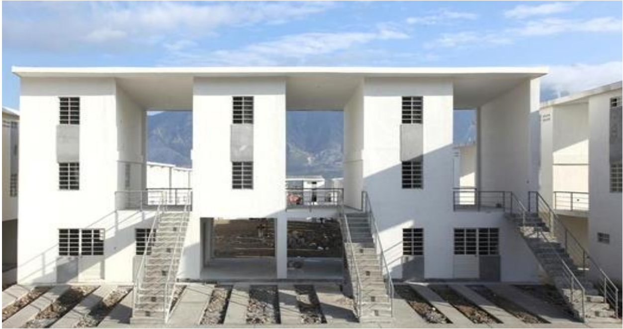
Figura8. Fachada de Monterrey. Fuente: “Plataforma de Arquitectura”.
