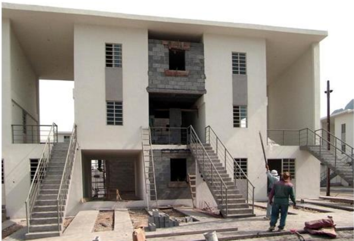
Figura9. Fachada de Monterrey Fuente: “Plataforma de Arquitectura”.
