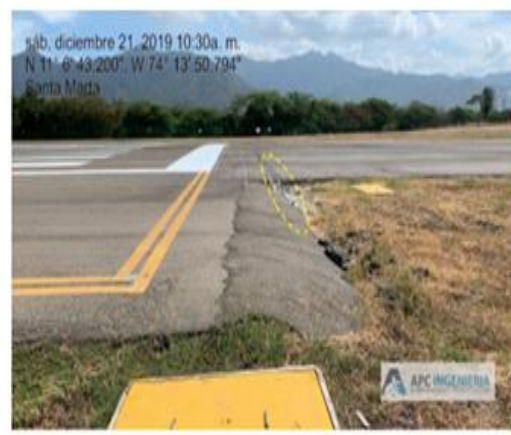
Cabecera 01, Parche de servicio por instalación de red seca.
