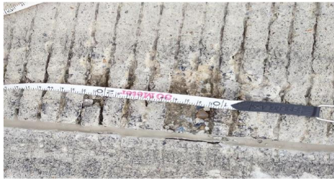
Ilustración 11: Pista Aeropuerto El Embrujó.
