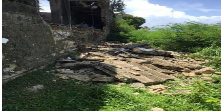
Fuente: Aeronáutica Civil – Administración del Aeropuerto ADZ, tomadas el 18 de junio de 2020.
