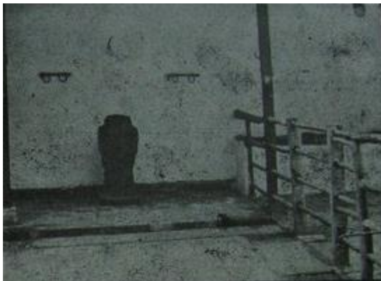
Figura 10. Caballerizas de la Casa de Bolívar
