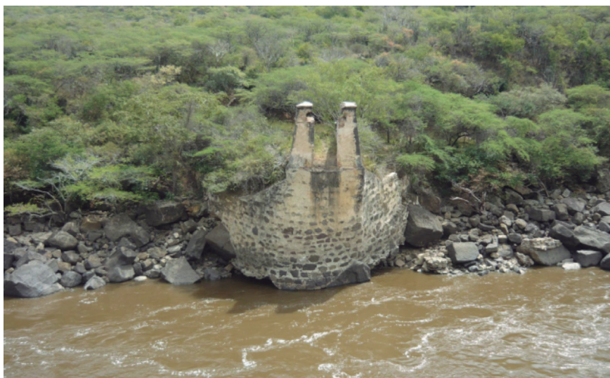
Figura 12. Ruinas del Puente Ruedas de Lengerke, antes de la construcción del nuevo puente
