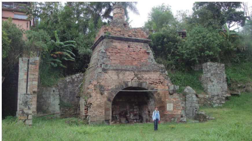
Figura 1. Ruinas de la Ferrería de Pacho
