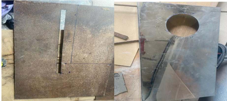
Figura 20. Cortes en láminas acero galvanizado de (60cm x 180cm), fuente: fotografía propia
