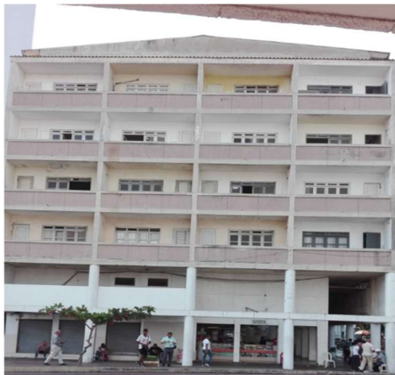
FOTOGRAFÍA 3.FACHADAS NORTE Y ESTE DEL EDIFICIO DAVID, AÑO 2016. LAS PÉRGOLAS VERTICALES DE AMBAS FACHADAS HAN SIDO RETIRADAS POR EFECTOS DE SEGURIDAD
