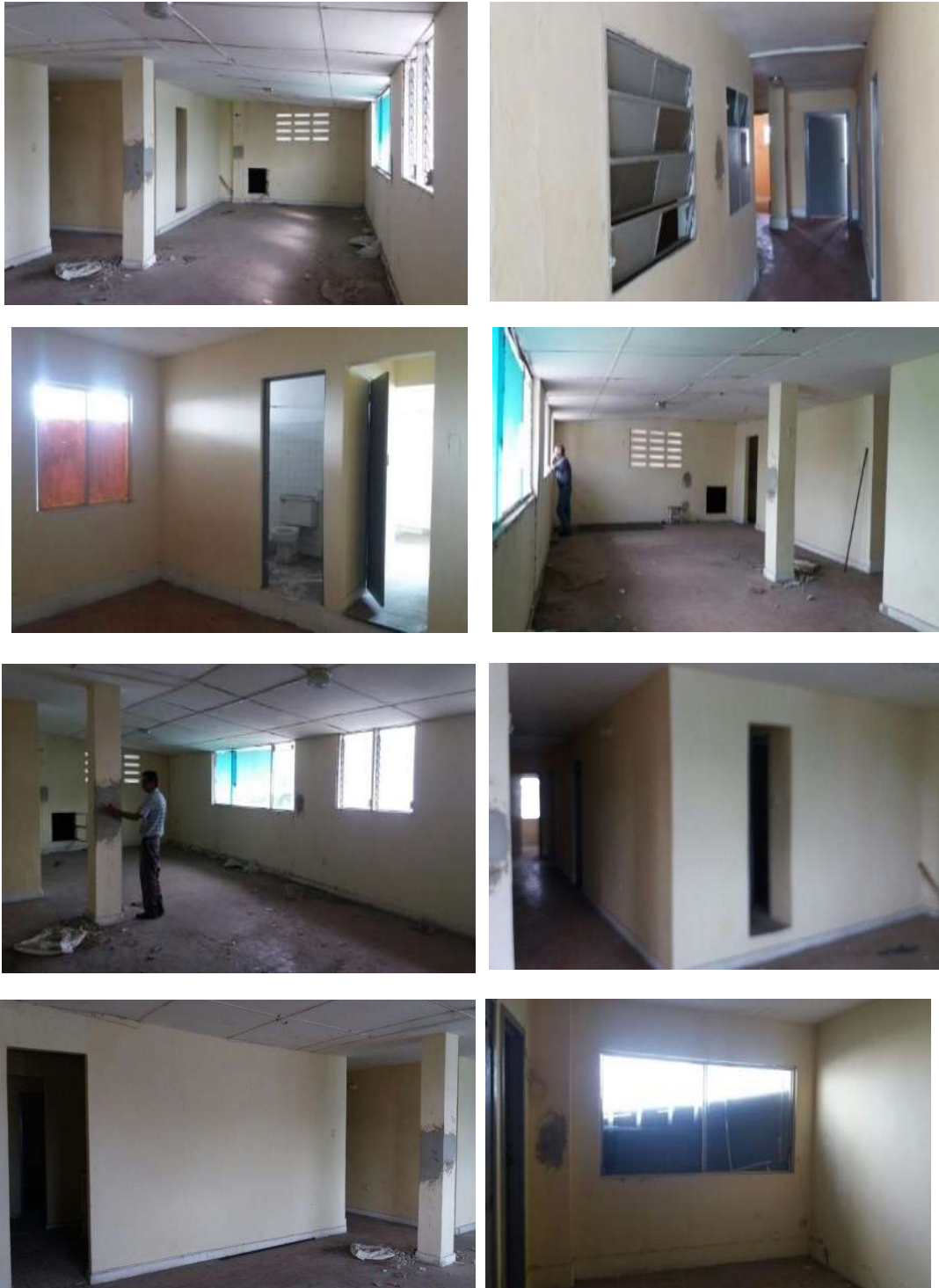
FOTOGRAFÍA 4. FOTOS INTERNAS DEL PENT-HOUSE EN EL SEXTO PISO DEL EDIFICIO DAVID
