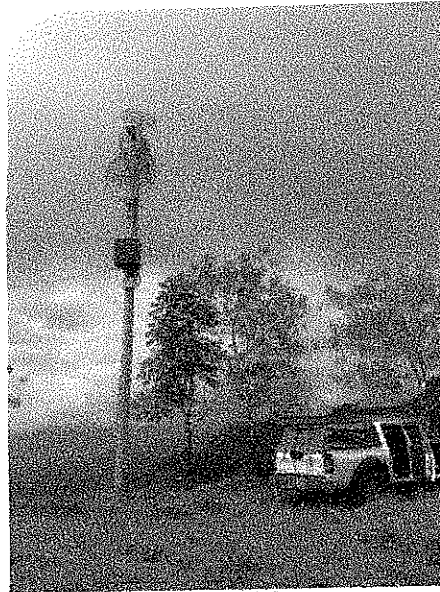
Figura 35. Repetidor muzo. Fuente. Autor
