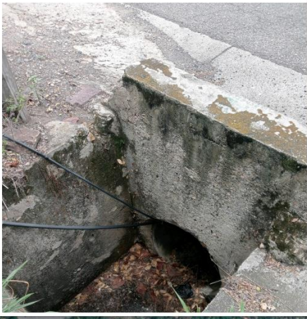
Limpieza de alcantarillas, Soatá.
