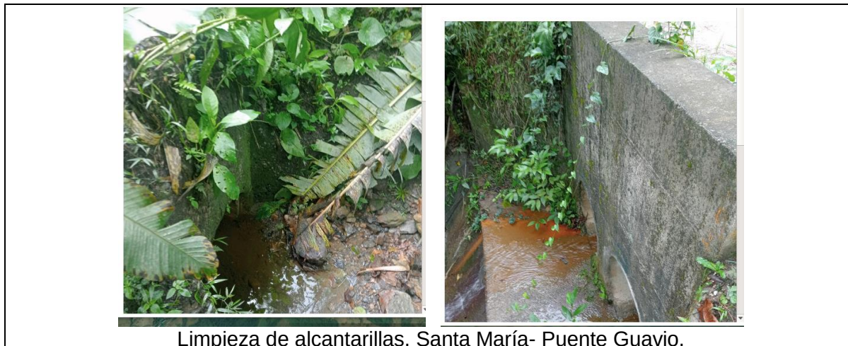
Figura 5. Cuadro resumen de evidencias fotográficas de la salida a campo a las obras del contrato 3437 de 2023
