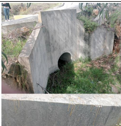
Limpieza de alcantarillas municipio de Turmequé
