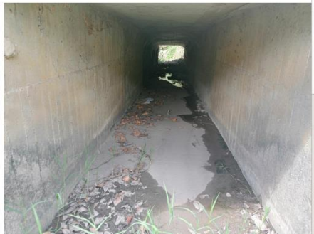
Limpieza de box couvert, Guateque.
