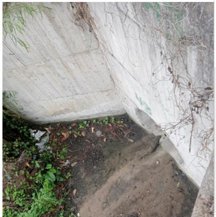
Limpieza de alcantarillas, Jenesano.
