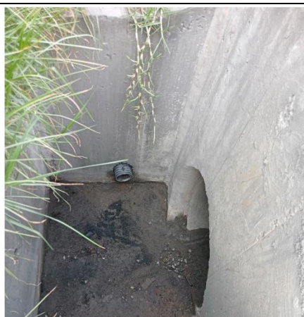
Limpieza de Alcantarillas en Sogamoso
