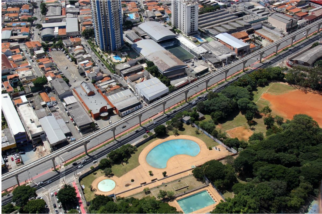
Figura 66. Estructura Monorriel elevado de Sao Pablo - Brasil.
