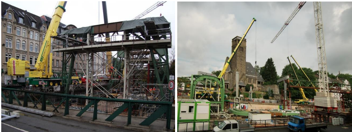
Figura 77. Mantenimiento Estructura Monorriel Wuppertal-Alemania.
