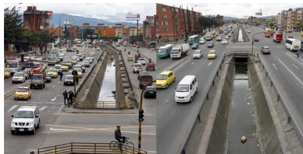
FIGURA 39. Tramo4 Calle 22-Calle 127.
