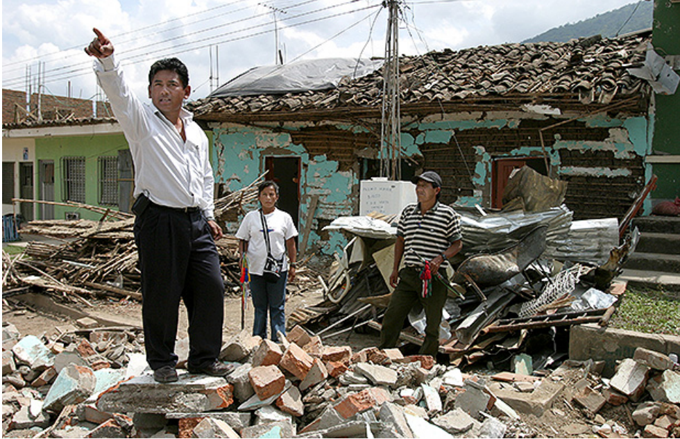
Ilustración 3: Reconstrucción viviendas afectadas por la explosión de “chiva bomba”
