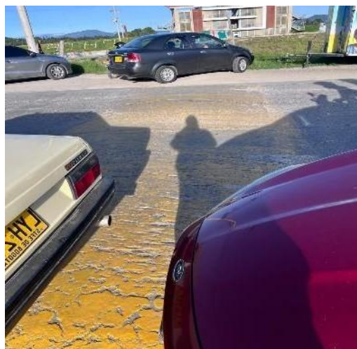
Figura 8. Punto proyectado para la construcción del pompeyano.
