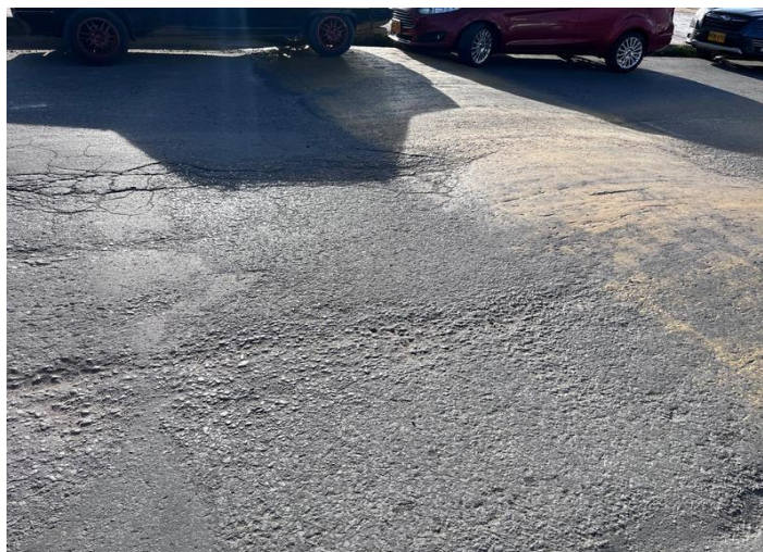
Figura 7. Punto proyectado para la construcción del pompeyano.
