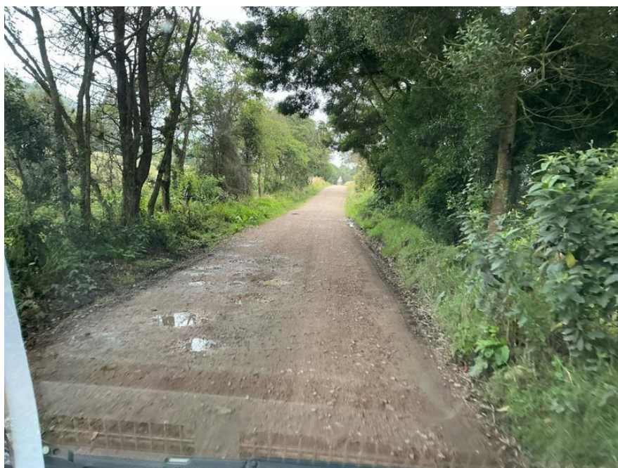
Figura 21. Zona donde se recomendó la construcción de un box culvert.
