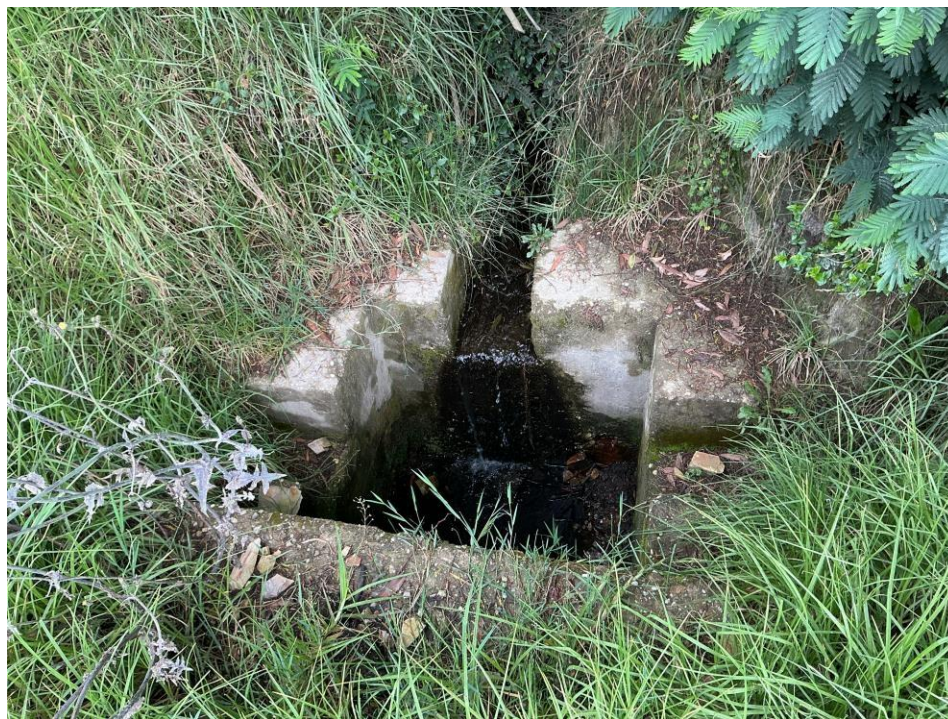
Figura 20. Alcantarilla existente durante la visita técnica.
