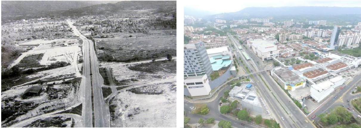
Figura 28. Cañaveral 1967 / 2015. Imagen aérea donde se muestra la ocupación generada por la construcción de objetos arquitectónicos en Cañaveral. Adaptado de Carlos Eslava (izquierda) – Arq. Wilmar Marulanda (Derecha).
