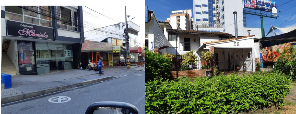
Figura 30. Tipología de vivienda y cambio de uso. Izquierda cambio de uso residencial por actividad de comercio de bajo impacto, Derecha tipología de vivienda inicial de Cañaveral construida en 1970, que contrasta con la edificación en altura situada en manzanas aledañas al fondo y con el cambio de fachada de otros inmuebles de la zona.
