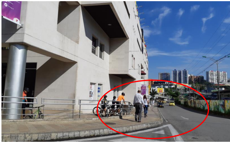
Figura 45. Pérdida del espacio público.
