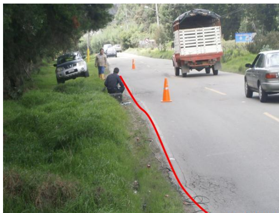
Figura 1. Patologías en la vía Siberia – Tenjo, generadas por cambios volumétricos del suelo.
