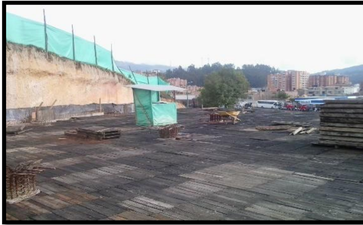
FIGURA 6. PLACA DE CONTRAPISO 2. FUENTE: CONSTRUCTORA
