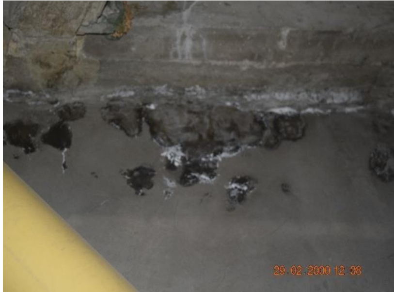
FIGURA 45. FALLA 3. FUENTE: PROPIA
