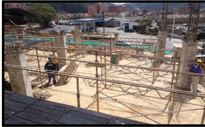
FIGURA 8. ESTRUCTURA 1 DEL SÓTANO. FUENTE: CONSTRUCTORA
