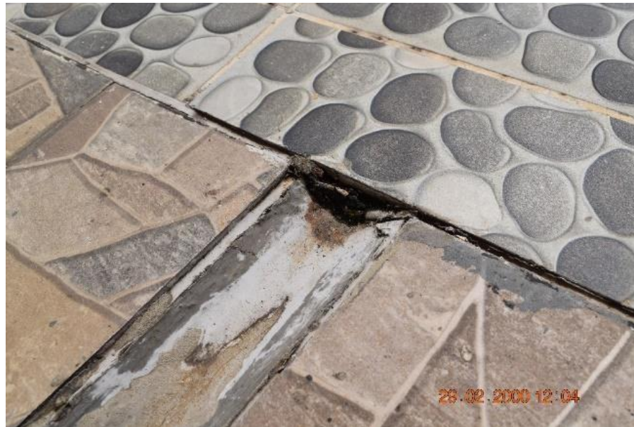
FIGURA 59. FALLA 10. FUENTE: PROPIA
