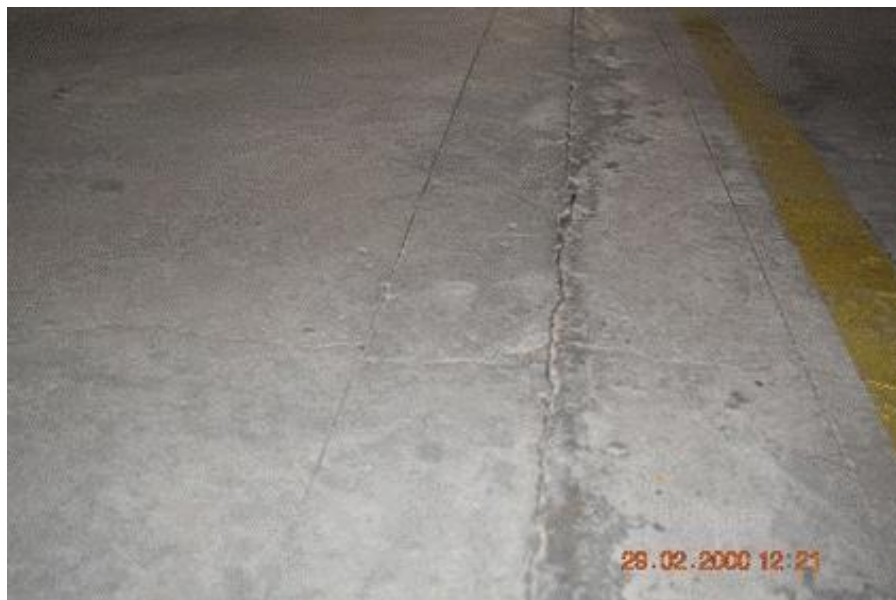
FIGURA 57. FALLA 9. FUENTE: PROPIA
