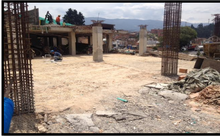
FIGURA 5. PLACA DE CONTRAPISO 1. FUENTE: CONSTRUCTORA
