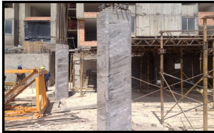
FIGURA 9. ESTRUCTURA 2 DEL SÓTANO. FUENTE: CONSTRUCTORA
