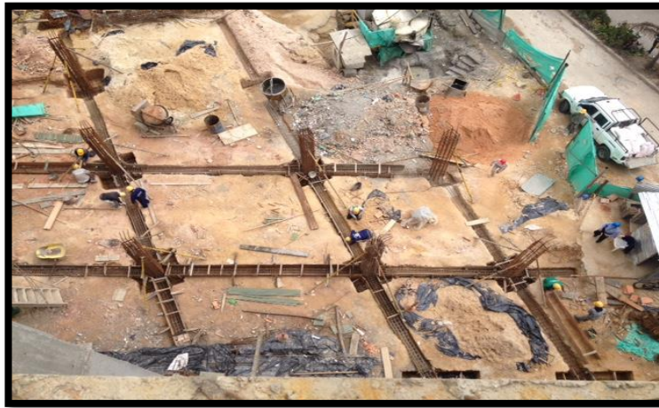
FIGURA 4. PROCESO CONSTRUCTIVO CIMENTACION. FUENTE: CONSTRUCTORA
