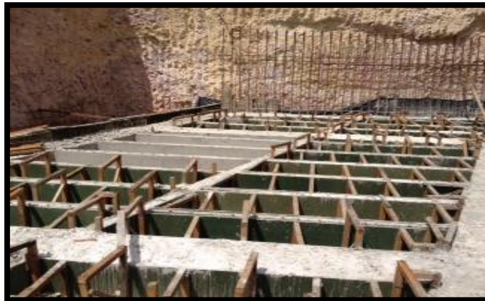
FIGURA 7. PLACA DE CONTRAPISO DEL SÓTANO. FUENTE: CONSTRUCTORA
