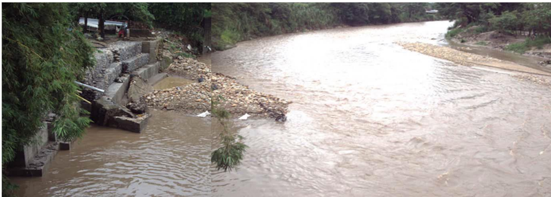
Fotografía 1.(Cauce del río aguas arriba- estudios anteriores .)
